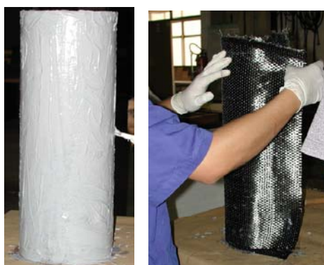
Figura 7.7 – Aplicação do sistema de reforço
