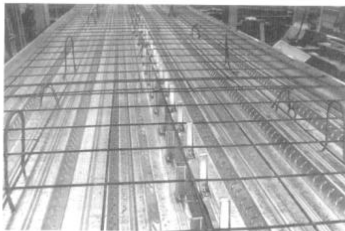
FIGURA 2.13: Conector da Hilti HVB em fôrmas de aço, QUEIROZ (2001)
