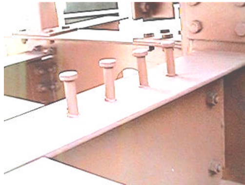
FIGURA 2.9: Resultado final da soldagem do conector tipo pino com cabeça (stud)
