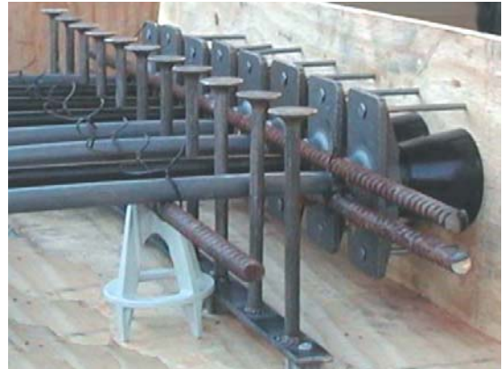
Figura 2.49 – Posicionamento de ancoragens na fôrma
