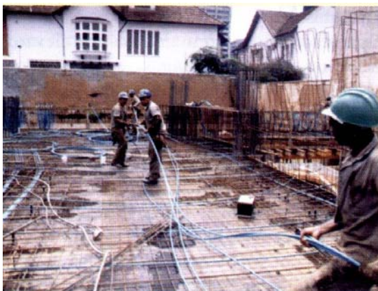
Figura 2.46 – Lançamento das armaduras ativa e frouxa (GRAZIANO [2000])
