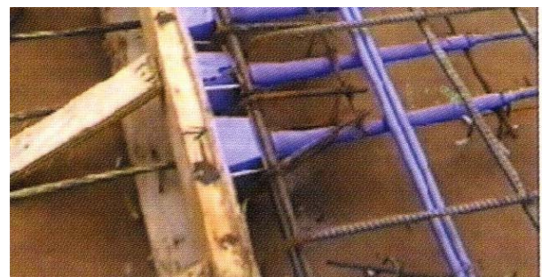
Figura 2.51 – Detalhe construtivo mostrando a ancoragem posicionada (GRAZIANO [2000])
