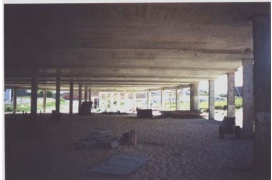
Figura 2.62 – Vão livre do pavimento térreo da estrutura
