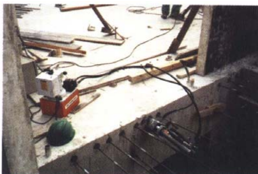
Figura 2.50 – Protensão de cordoalha com macaco hidráulico (GRAZIANO [2000])
