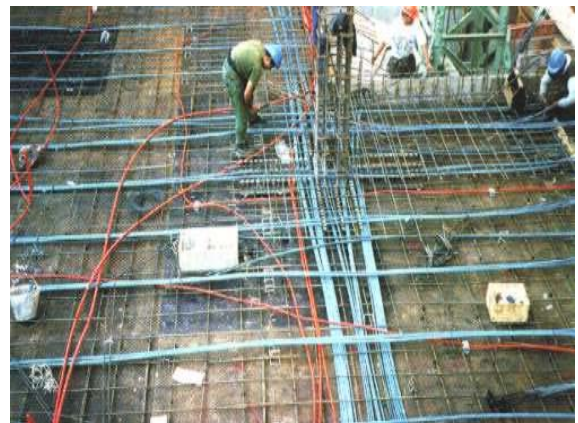
Figura 2.47 – Inspeção da passagem de armadura ativa pelo pilar (GRAZIANO [2000])
