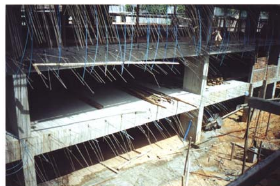
Figura 2.59 – Ancoragens no pavimento
