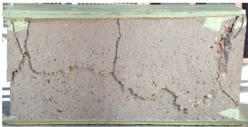
Figura 6.2 - Ruptura típica dos blocos vazados de concreto de alvenaria com função estrutural
