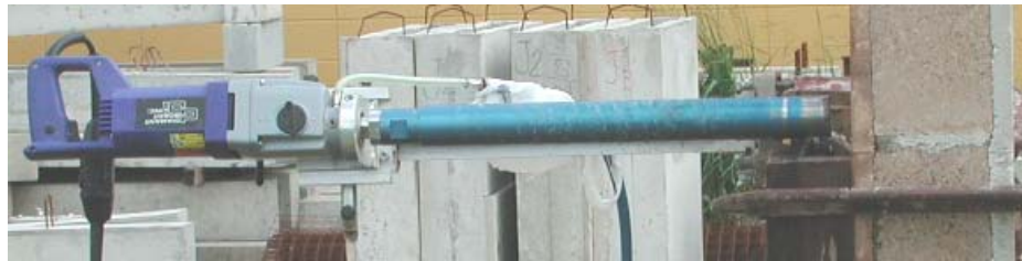
a) Vista da perfuratriz fixada à alvenaria
