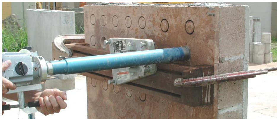
b) Vista do posicionamento da perfuratriz ao guia para o corte do revestimento
