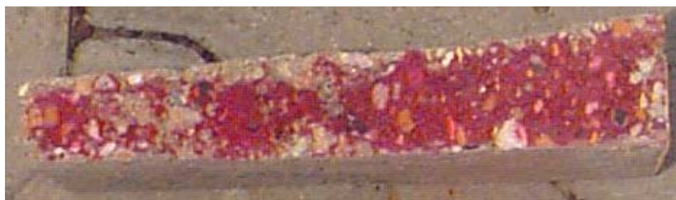
Figura 6.15 - Profundidade de carbonatação no bloco de concreto
