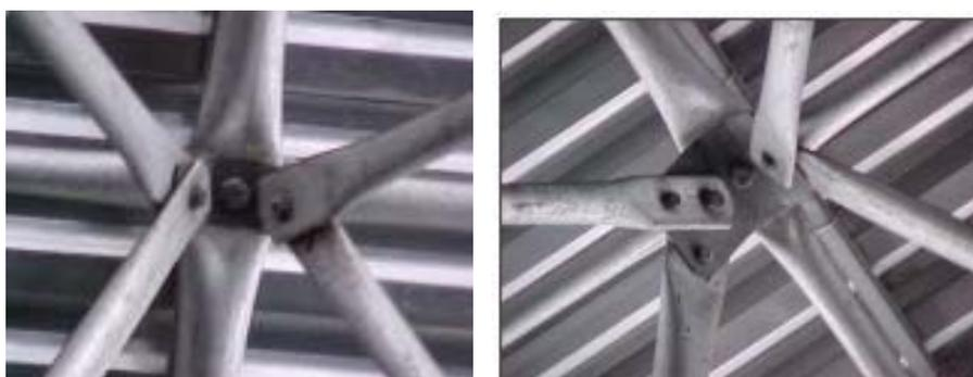
Figura 2.24 – Sistema de nó típico com chapa de diagonal
