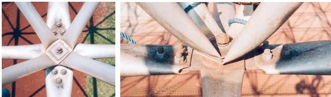
Figura 2.23 – Sistema de nó típico com chapa de banzo
