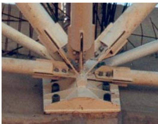
Figura 2.27 – Sistema de nó de aço com barras com ponteiras
