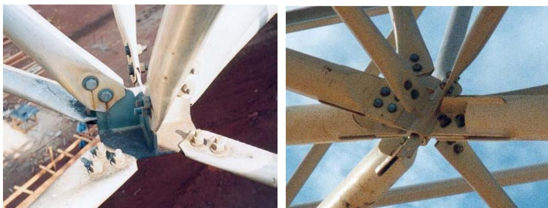
Figura 2.25 – Sistemas de nó de aço – o primeiro mais utilizado em treliças espaciais planas, e o segundo em arcos e cúpulas espaciais
