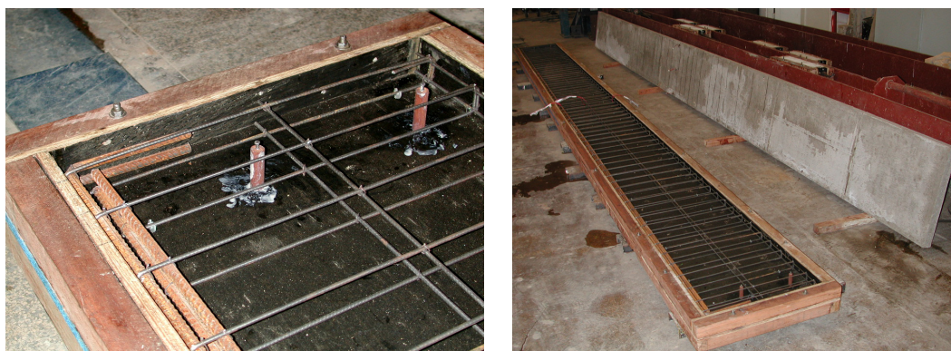
Figura 6.17 – Roletes de madeira posicionados na fôrma antes da concretagem.
