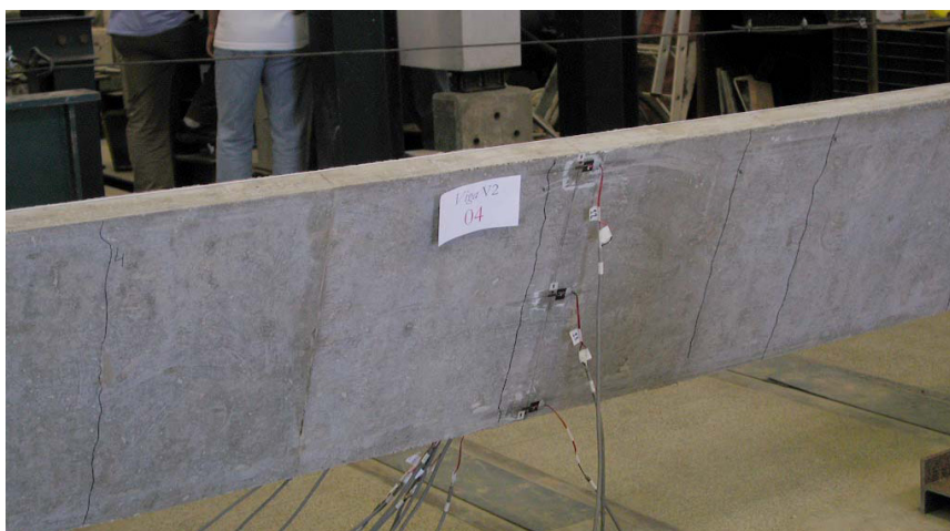
Figura 6.26 – Início do quadro de fissuração na etapa 4.
