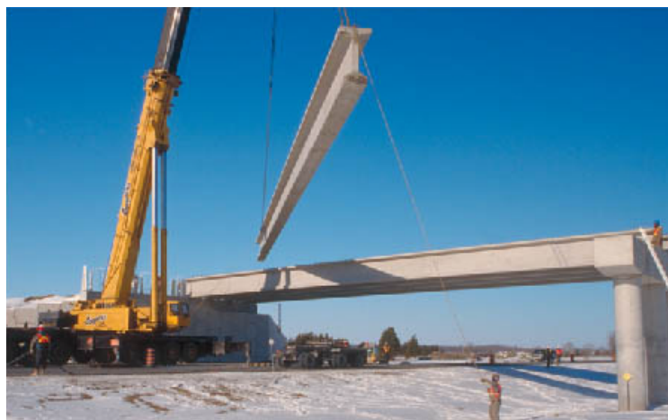
Figura 7.46 - Exemplo de içamento com cabos inclinados de uma viga pré-moldada.
