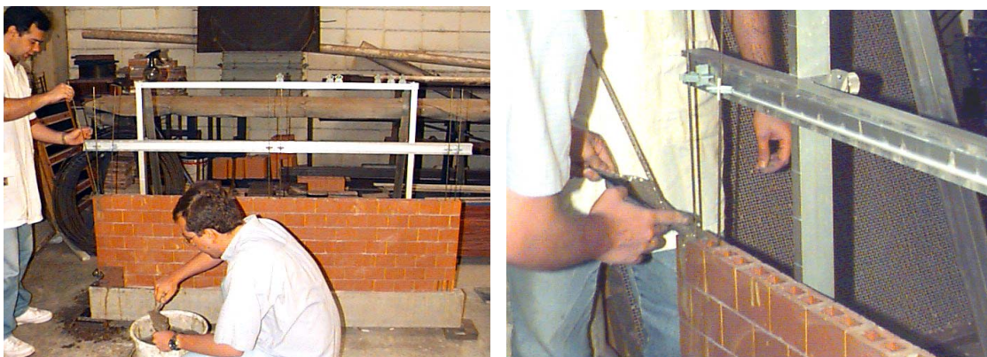
Figura 3.19 Operação de grauteamento do Modelo 6.
