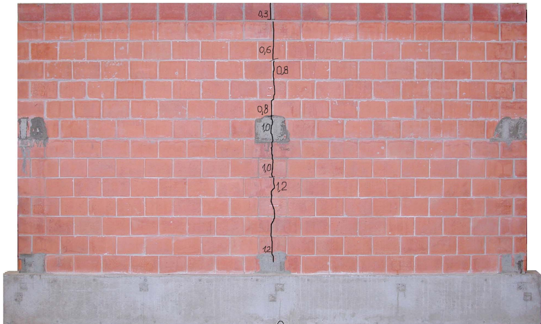
Figura 4.91 Fotografia do painel após ensaio – Modelo 6, Situação 3. (Verso do painel)
