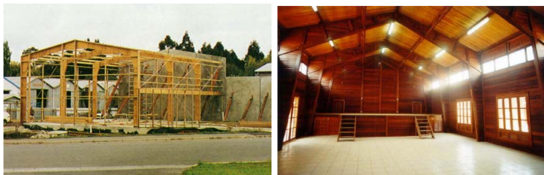
Figura 5 – esq.: Estrutura de residência utilizando madeira compensada - fonte: IPL. Dir.: Pórtico composto de madeira maciça e almas em compensado construído pela CASEMA em Guaratinguetá - SP - fonte: do autor.
