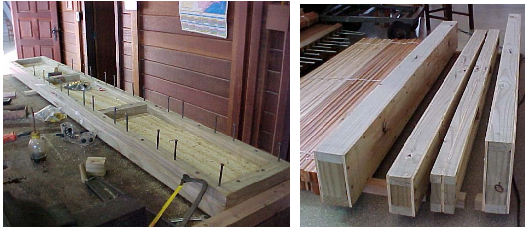
Figura 28 – Montagem das vigas compostas
