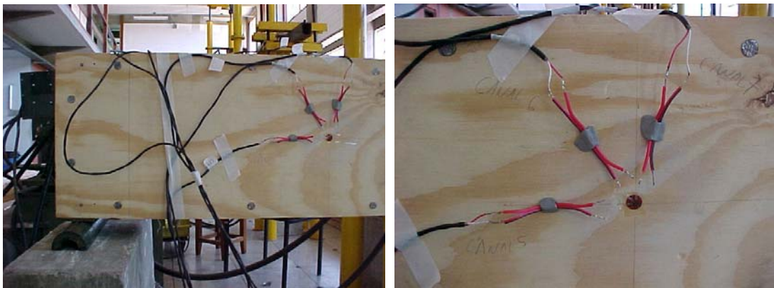
Figura 32 – Posicionamento dos extensômetros elétricos e rosetas (nas fotos) nas vigas instrumentadas
