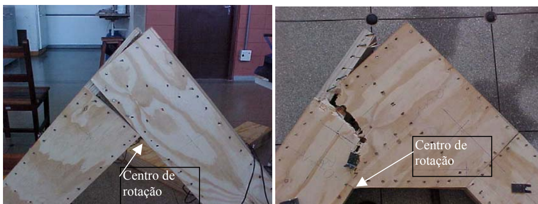
Figura 52 – Ruptura de nó de pórtico apresentando o centro de rotação relativa entre as vigas.
