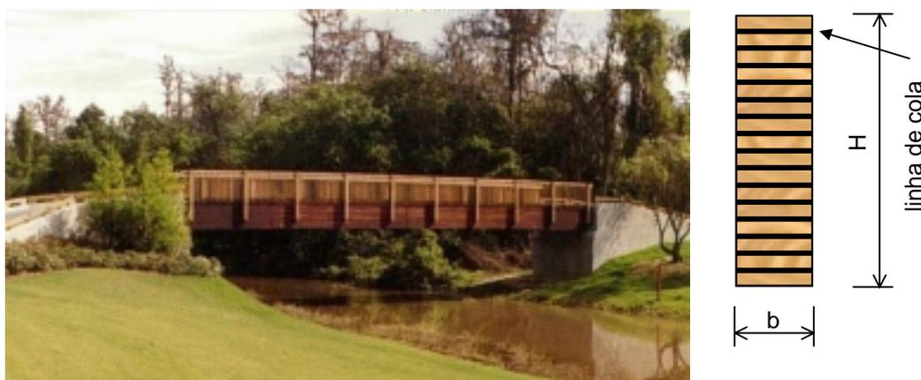
Figura 2.9 – Ponte com Vigas Laminadas Coladas
