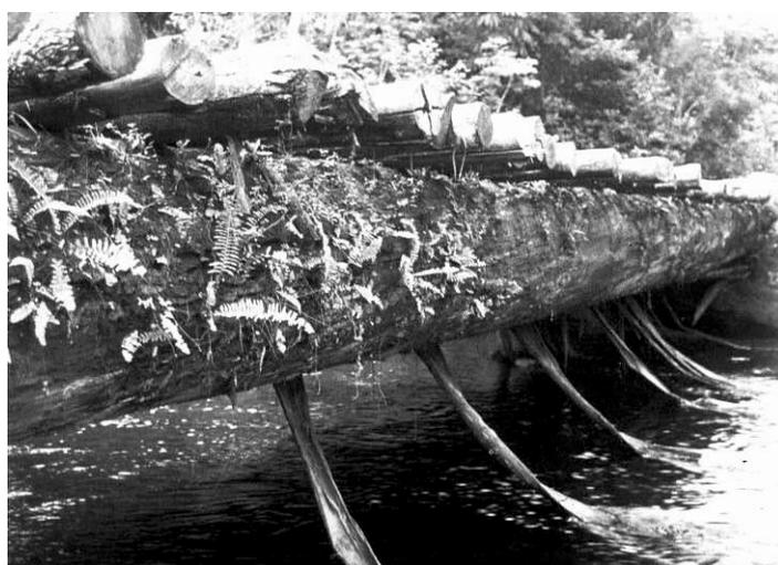
Figura 2.5 – Ponte em Viga com peças roliças simples
