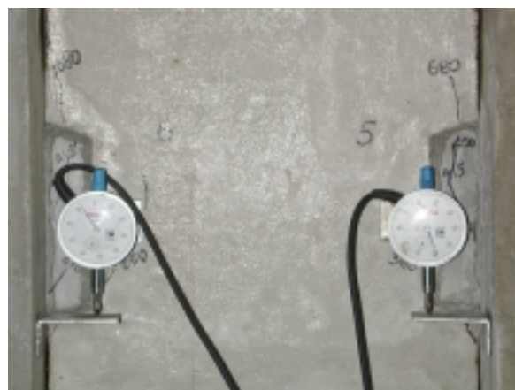
Fissuração na peça pré-moldada antes da ruptura da ligação – CP25
