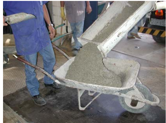
(a) chegada do caminhão; (b) - concreto sendo depositado nas carruagens;
