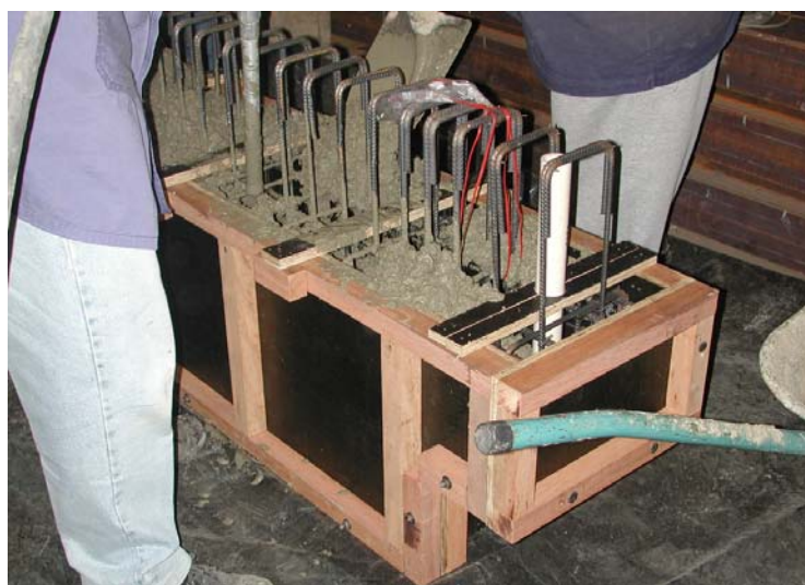
(d) - concretagem das vigas;
