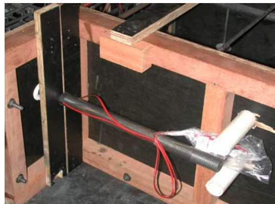
Figura 4.52 - Armadura na fôrma do pilar.
