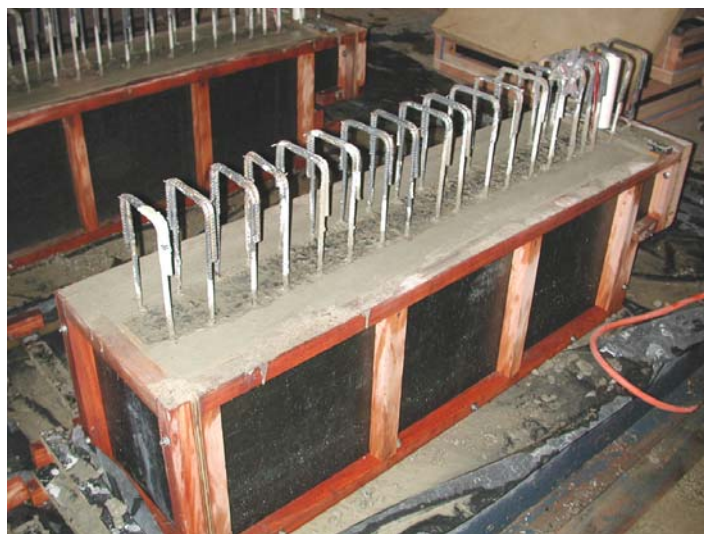
(g) - viga moldada;
