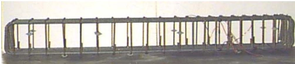
(a) - armadura das vigas;
