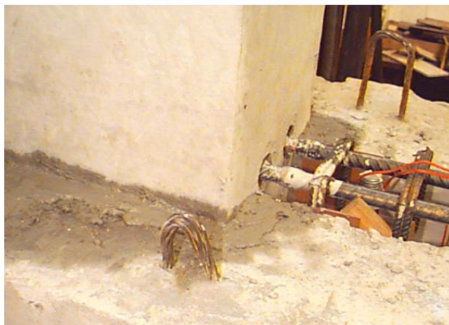
Figura 4.62 - Grauteamento dos espaços entre as lajes e o pilar (modelo 2.1).
