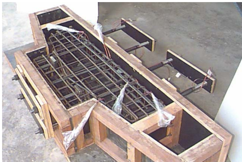
Figura 4.9 - Armadura na fôrma e dispositivo de fixação dos chumbadores.
