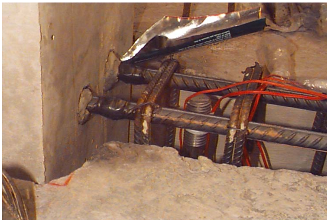
Figura 4.60 - Grauteamento dos furos do pilar.
