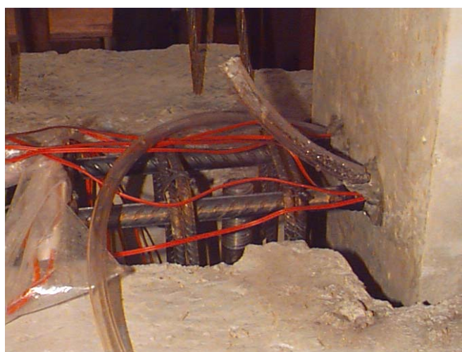
Figura 4.61 - Respiro para expulsão das bolhas de ar.
