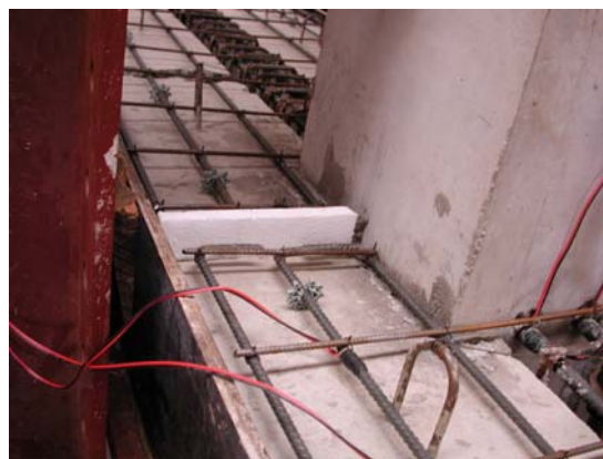
Figura 4.64 - Solução para garantir a descontinuidade da capa do modelo 2.2.
