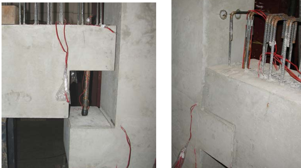
(e) - posicionamento da viga - detalhe; (f) - vista da viga apoiada sobre o consolo;
