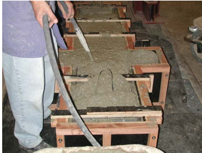
(e) - concretagem do pilar;
