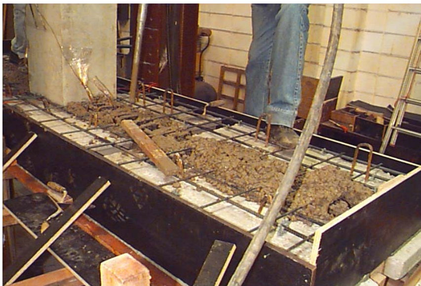
Figura 4.65 - Concretagem da capa (modelo 2.1).
