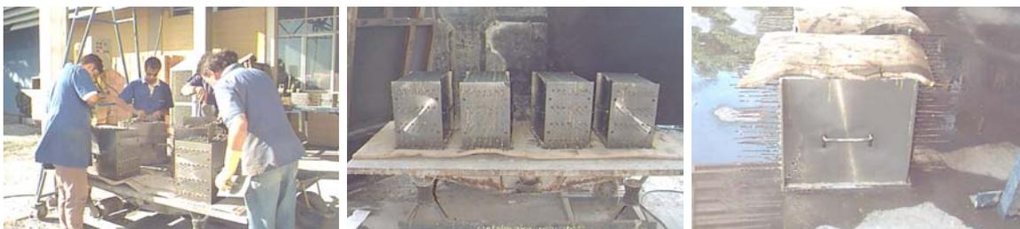
Figura 4.11 – Fotos da concretagem, adensamento e cura dos painéis PA-40
