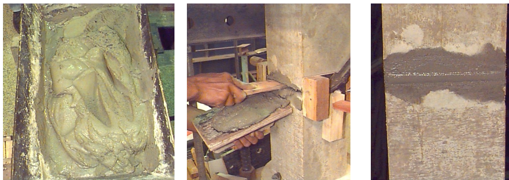
a) argamassa “Dry Pack” b) preenchimento da junta c) junta executada
