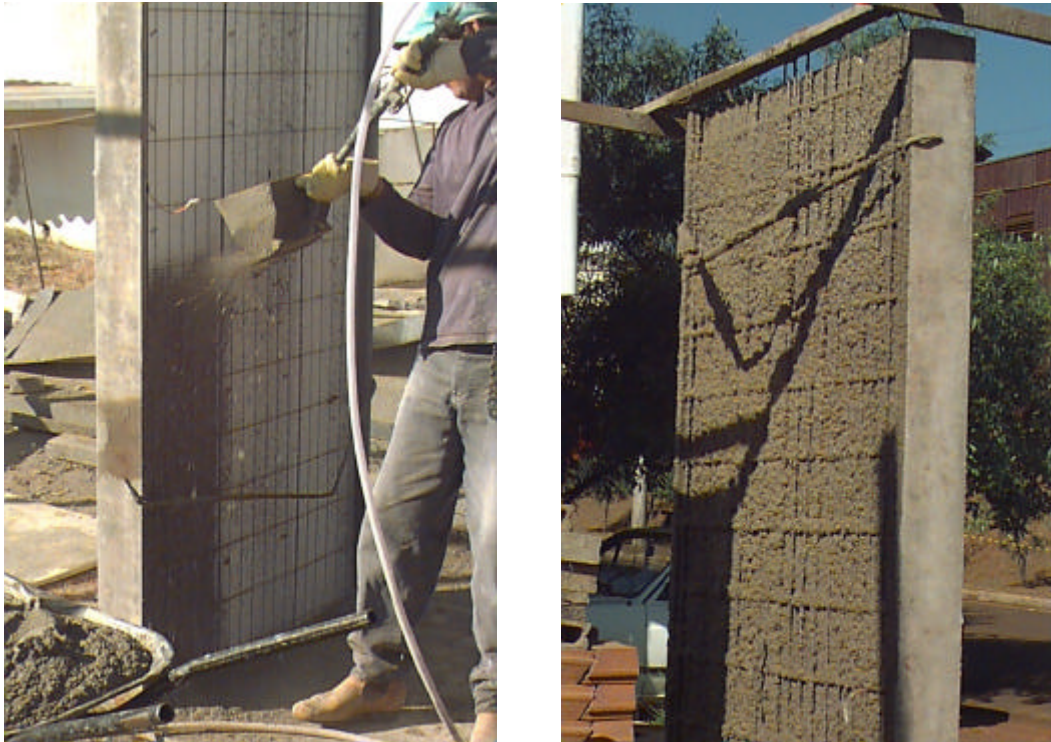
FIGURA 7.8 – PRIMEIRA ETAPA DA PROJEÇÃO DA ARGAMASSA
