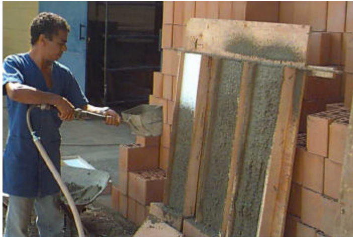
FIGURA 5.9 – 1ª ETAPA DA PROJEÇÃO DOS PAINÉIS
