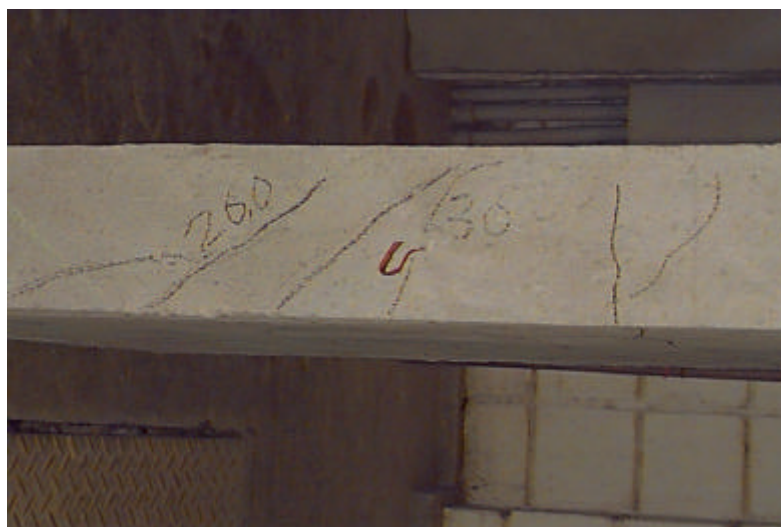
FIGURA 7.19 – FISSURAS NUMA ETAPA DO ENSAIO PRÓXIMA DA RUPTURA - PSF-IV
