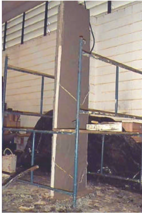
FIGURA 6.14 – FINAL DA PRIMEIRA ETAPA DA ARGAMASSAGEM
