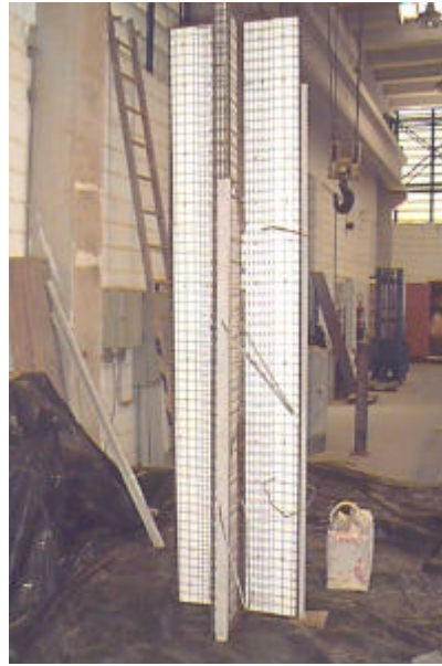
FIGURA 6.12 – VIGA NA POSIÇÃO VERTICAL, PREPARADA PARA O INÍCIO DA ARGAMASSAGEM
