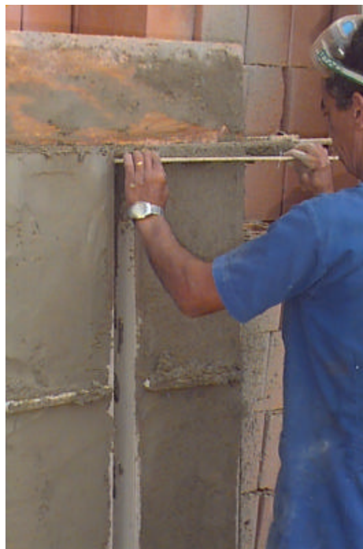
FIGURA 5.10 - RETIFICAÇÃO DA ESPESSURA DOS PAINÉIS
