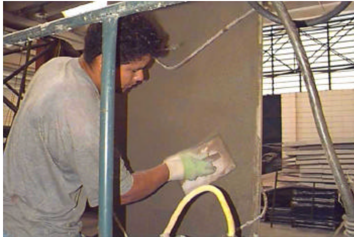
FIGURA 6.16 – FASE DE ACABAMENTO
