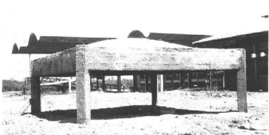
FIGURA 2.20 – VISTA DO PROTÓTIPO CONCLUÍDO (TEXEIRA, 1999).
