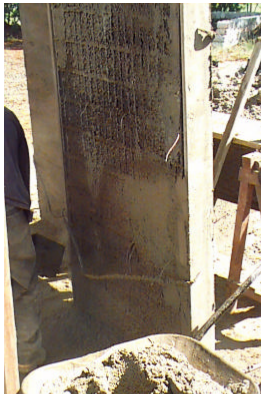
FIGURA 7.9 – SEGUNDA ETAPA DA PROJEÇÃO DA ARGAMASSA. SARRAFOS NAS LATERAIS
