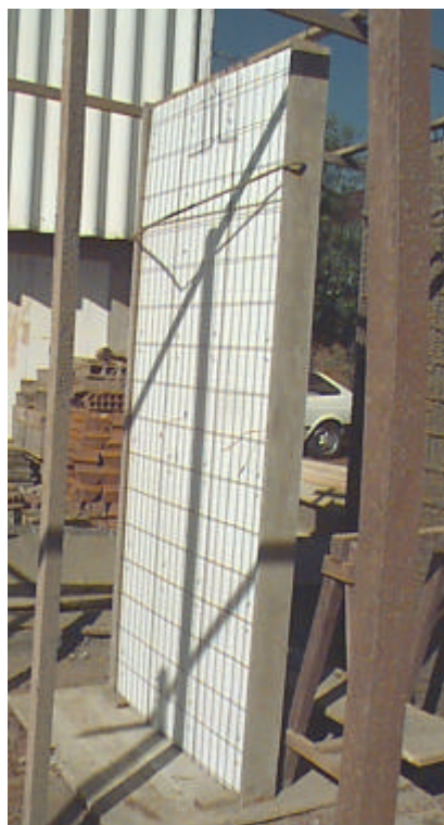
FIGURA 7.7 – PAINÉIS POSICIONADOS PARA PROJEÇÃO DA ARGAMASSA
