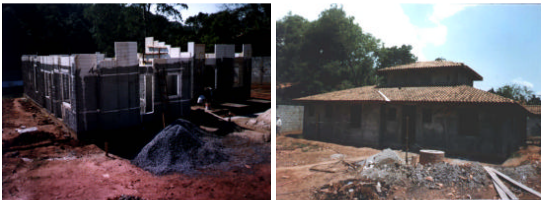
FIGURA 4.2 - CASA CONSTRUÍDA PELA CÓDIGO ENGENHARIA EM COTIA-SP
