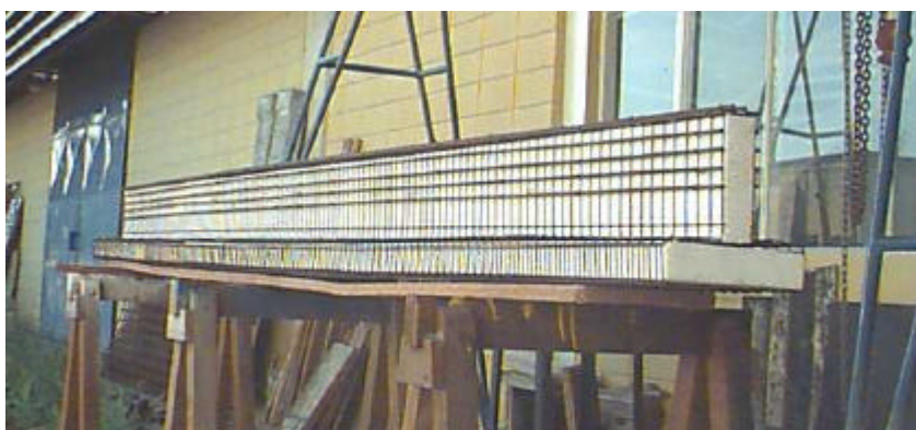
FIGURA C6 – VISTA LATERAL DA VT 01 PRONTA PARA O INÍCIO DA ARGAMASSAGEM.
