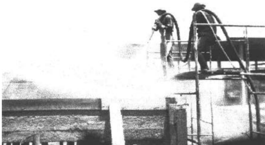
FIGURA 2.19 – CONCRETAGEM DA FACE SUPERIOR DO PROTÓTIPO (TEXEIRA, 1999).
