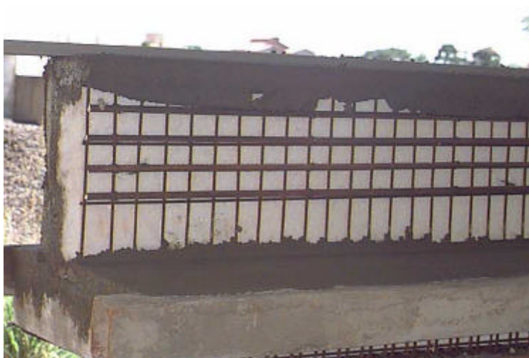
FIGURA C7 – PRIMEIRA ETAPA DA ARGAMASSAGEM. ALMA E PARTE INFERIOR DA MESA
