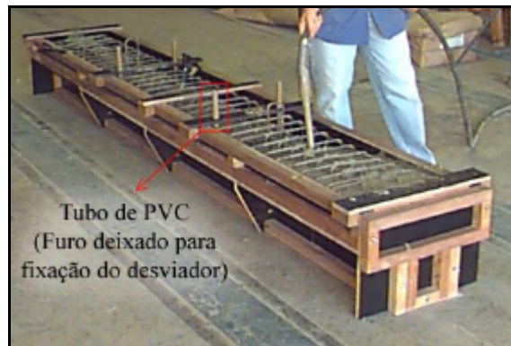
Figura 4.14 - Concretagem da viga VP-1
