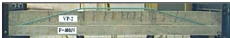
Após a protensão dos cabos.
