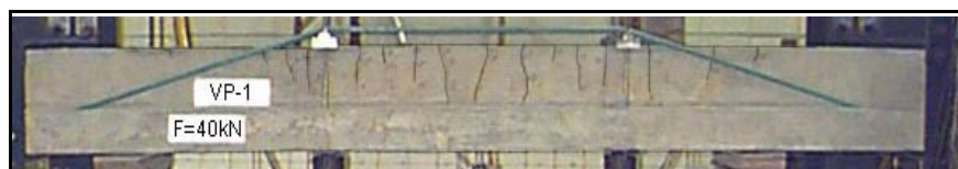
Após a protensão dos cabos.
