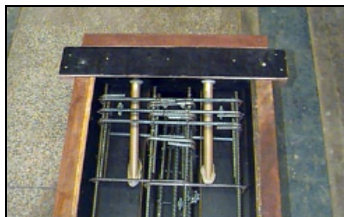
Figura 4.15 - Detalhe da extremidade da fôrma da viga VP-2
