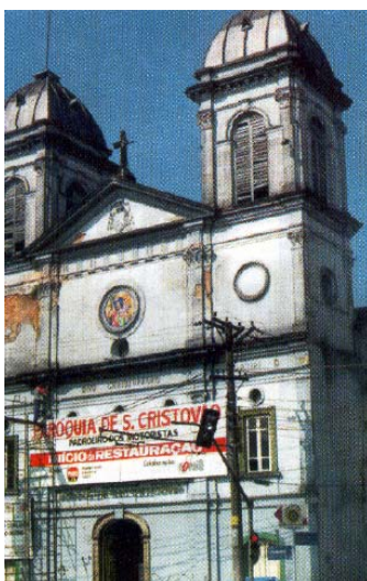
Figura 2.8 – Fachada da Igreja São Cristóvão - São Paulo antes da recuperação.
