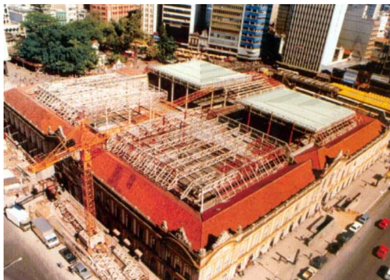
Figura 2.15 – Execução da cobertura – Mercado Público fonte: Revista Construção Metálica MAI/JUN 97
