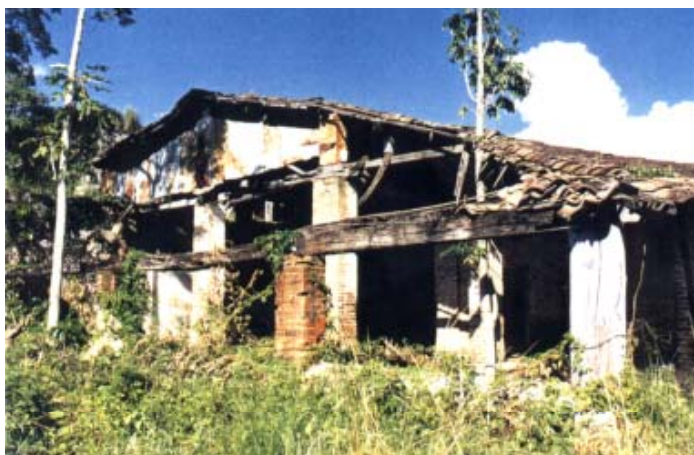
Figura 3.7 – Vista geral Edificação 2 . Caieira do Meio
