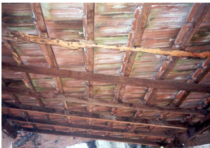
Figura 2.2 - Cobertura do Pavilhão de Exposição – Uberaba-MG- Ataques biológicos.
