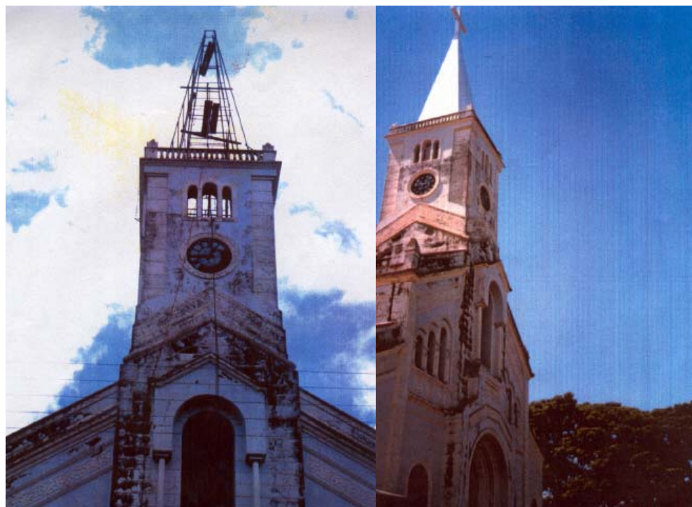
Figura 2.11 – Detalhe da recuperação da cobertura da Igreja Matriz de Conquista
