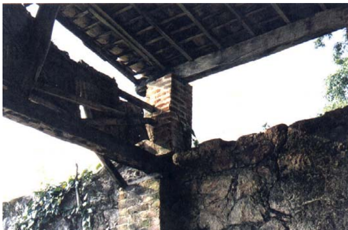
Figura 3.9 – Detalhe do pilar em alvenaria.
