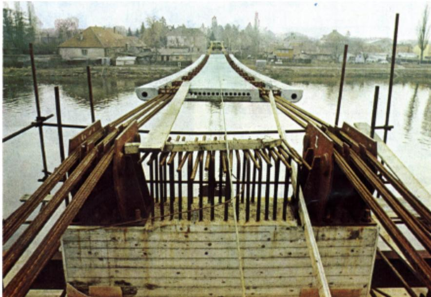
Figura 33 – Passarela em Nymburk – pilar intermediário com sela de aço.
