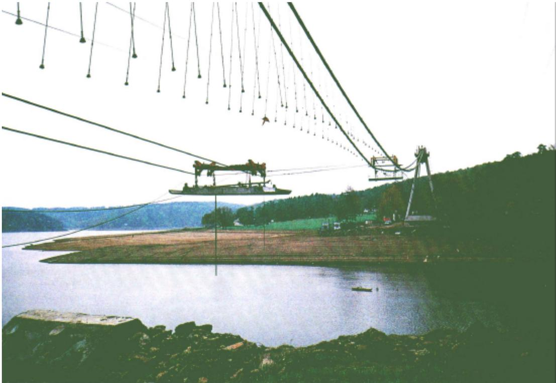
Figura 59 – Montagem do primeiro elemento do tabuleiro.
