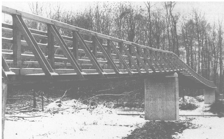
Figura 41 – Passarela formada por elementos de madeira. (STRASKY, 1990)
