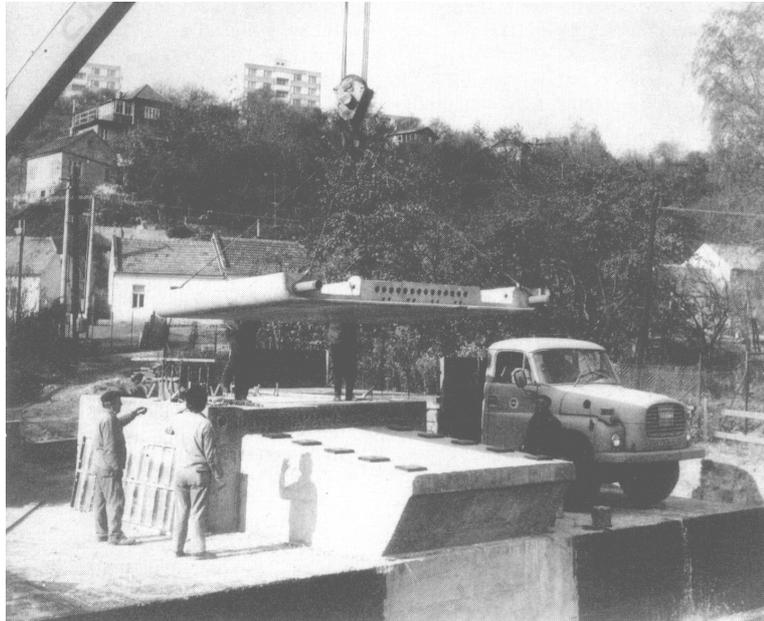
Figura 34 – Montagem do elemento de extremidade. (STRASKY & PIRNER, 1986)
