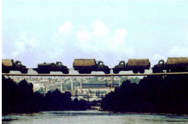
Figura 40 – Prova de carga. (STRASKY, 1999)
