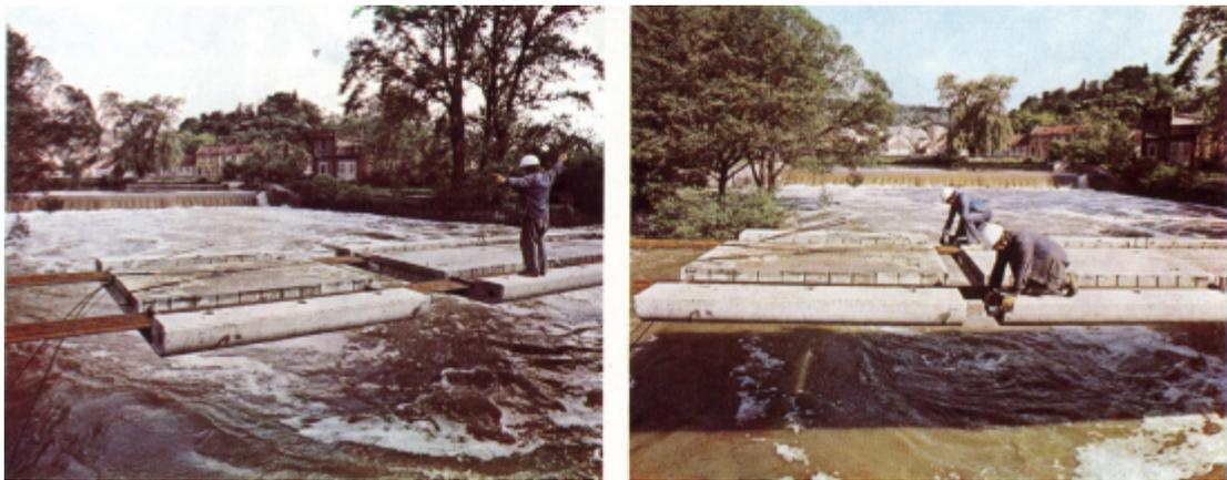
Figura 38 – Colocação de tubos de aço entre os elementos. (STRASKY & PIRNER, 1986)
