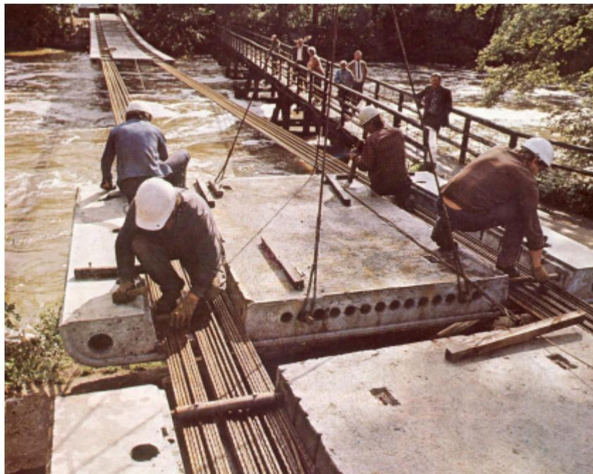
Figura 36 – Inserção de dispositivos para fixação do elemento aos cabos.
