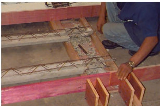
FIGURA 4.12 – Posicionamento das vigotas pré-moldadas
