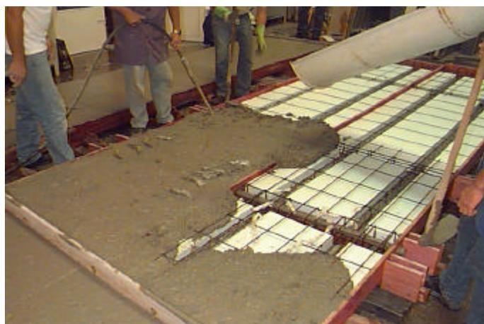
FIGURA 4.16 – Lançamento e adensamento do concreto
