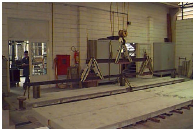
FIGURA 4.20 – Estrutura pronta para ser içada
