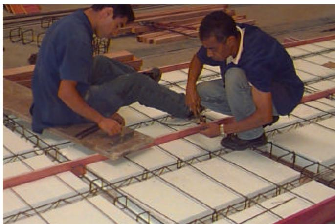
FIGURA 4.14 – Fixação da armadura de distribuição
