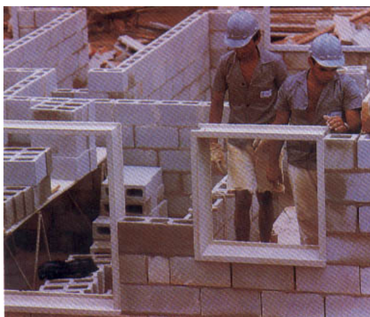
Figura 5.36: Assentamento de contramarco pré-moldado (Giassetti, 2000)
