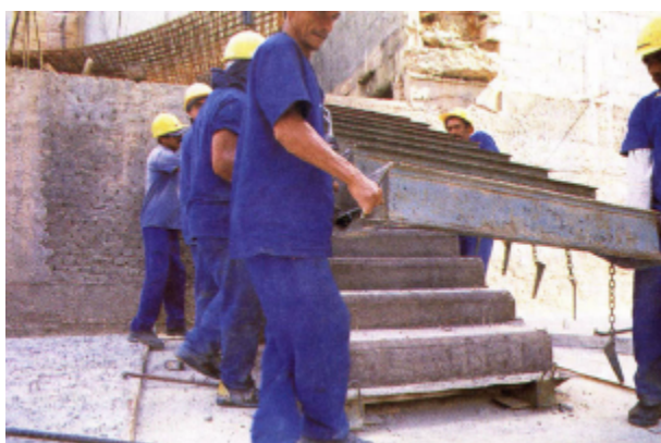
Figura 4.3: Escada pré-moldada produzida no canteiro de obra (KISS, 1998)
