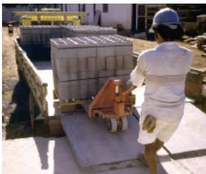
Figura 6.1: Figura de carro porta palete transportando bloco (cortesia do Eng. Marcio S. Faria)
