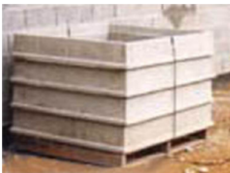
Figura 6.5: Contramarcos pré-moldados empilhados em forma de paletes
