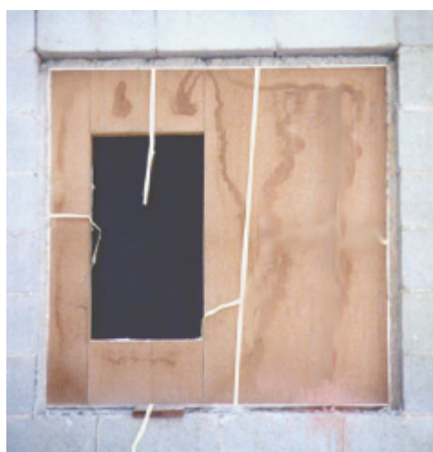
Figura 5.8: Foto da esquadria padronizada instalada vista externamente à edificação [a]; e detalhe do chumbamento da grapa [b]
