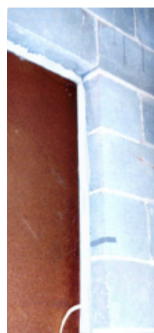
Figura 5.8: Foto da esquadria padronizada instalada vista externamente à edificação [a]; e detalhe do chumbamento da grapa [b]
