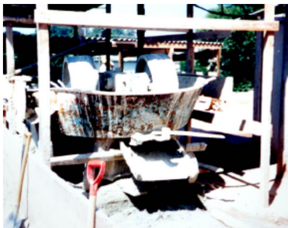
Figura 6.6: Moinho de reciclagem de resíduos no canteiro da obra
