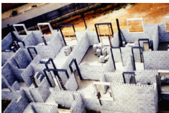
Figura 2.1: Vista superior de um edifício em alvenaria estrutural com incorporação de elementos pré-moldados leves (cortesia do Eng. Márcio S. Faria)
