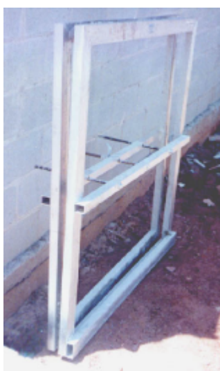
Figura 5.6: Gabarito metálico usado para o requadro do vão da alvenaria
