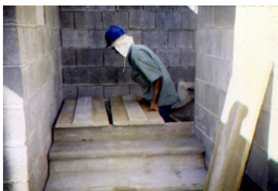
Figura 2.2: Execução de uma escada pré-moldada (cortesia do Eng. Marcio S. Faria)
