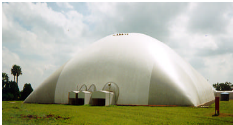
FIGURA 1.3: Estrutura pneumática, Armazém Industrial no Brasil [Fonte: Pistelli Engenharia Ltda. (1997)].
