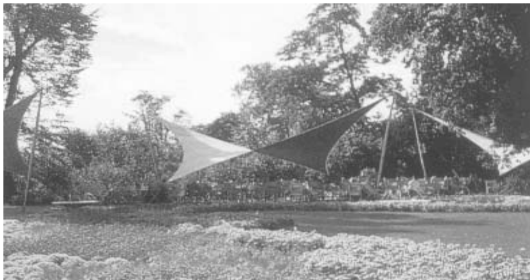
FIGURA 2.3.6: Pavilhão de Música de Kassel, Alemanha, 1955 (VANDENBERG, 1996).
