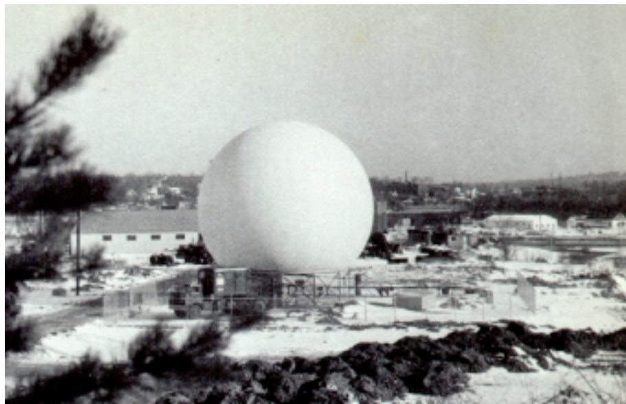
FIGURA 2.2.6: Primeira cobertura pneumática, radome , cobertura de radar em clima ártico (KAMRASS, 1956).
