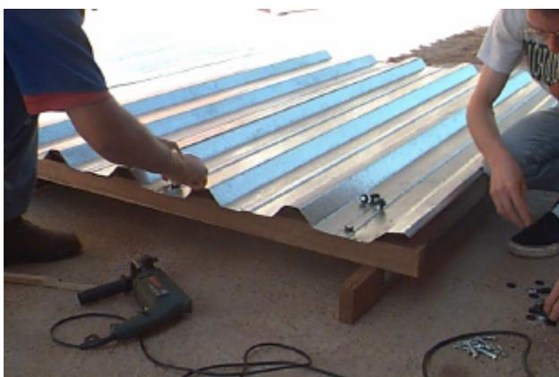
FIGURA 25 – Fixação das telhas
