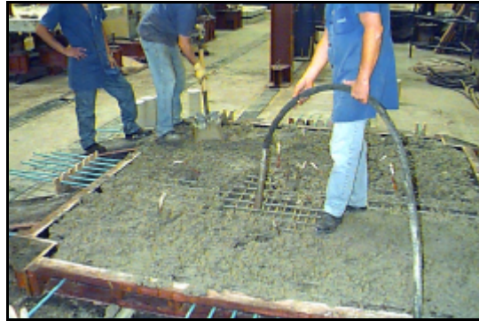
b) Laje de concreto protendido
