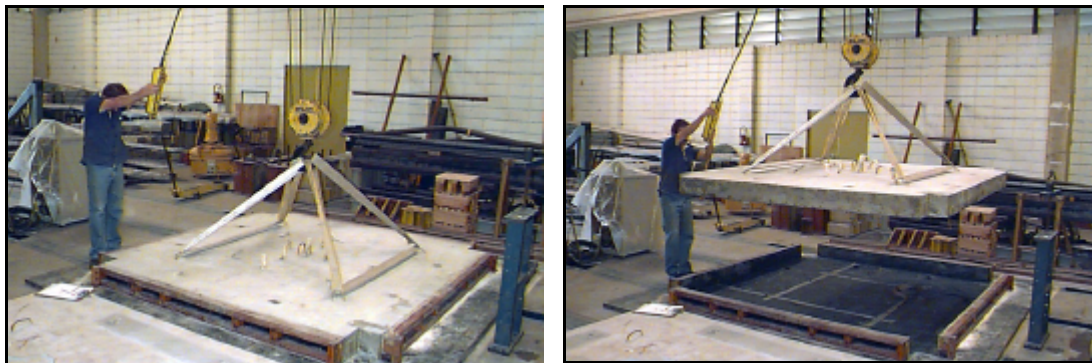
Figura 3.38 - Desforma dos modelos de concreto armado
