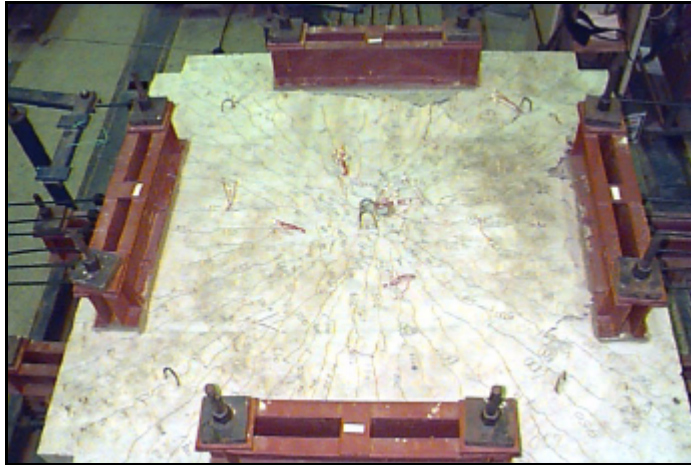
Figuras 4.145 - Vista da face superior, após a ruptura do modelo, mas em fase anterior ao carregamento pós-ruptura.
