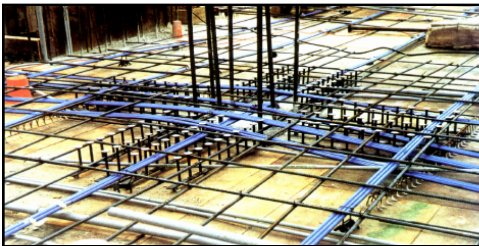
Figura 2.42 - Aplicação de conectores tipo pino em laje plana protendida
