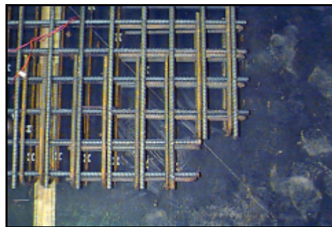
Figura 3.52 - Detalhe da armadura em U
