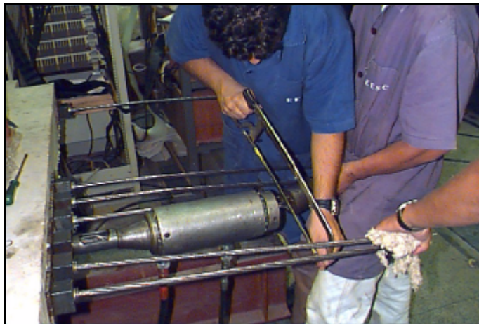
Figura 3.23 - Corte de uma cordoalha rompida, visando liberar o macaco
