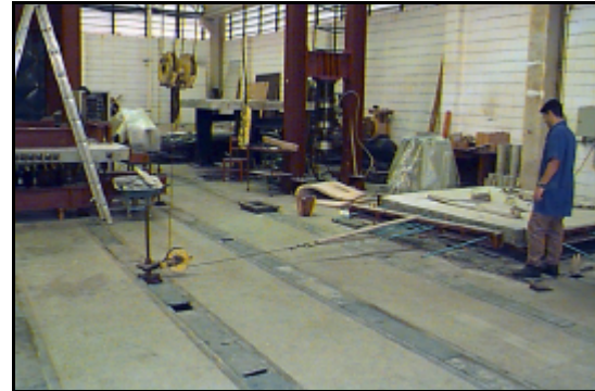
Figura 3.40 - Retirada da face lateral da fôrma
