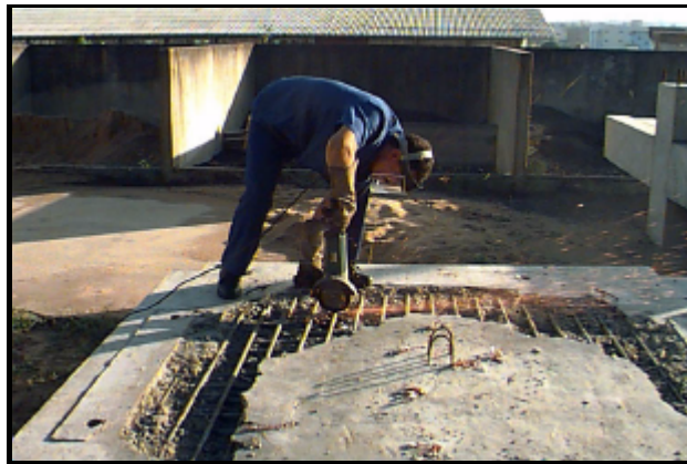
Figura 4.127- Corte das barras junto à face superior
