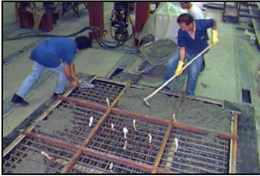
a) Laje de concreto armado
