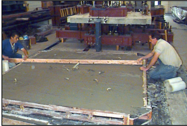
Figura 3.36 - Ajuste do nível do concreto com o auxílio de uma régua de madeira
