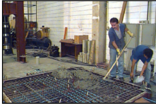
b) Laje de concreto protendido
