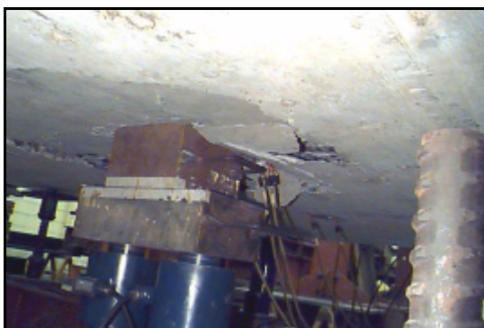
Figuras 4.143 - Ruptura na face inferior do modelo
