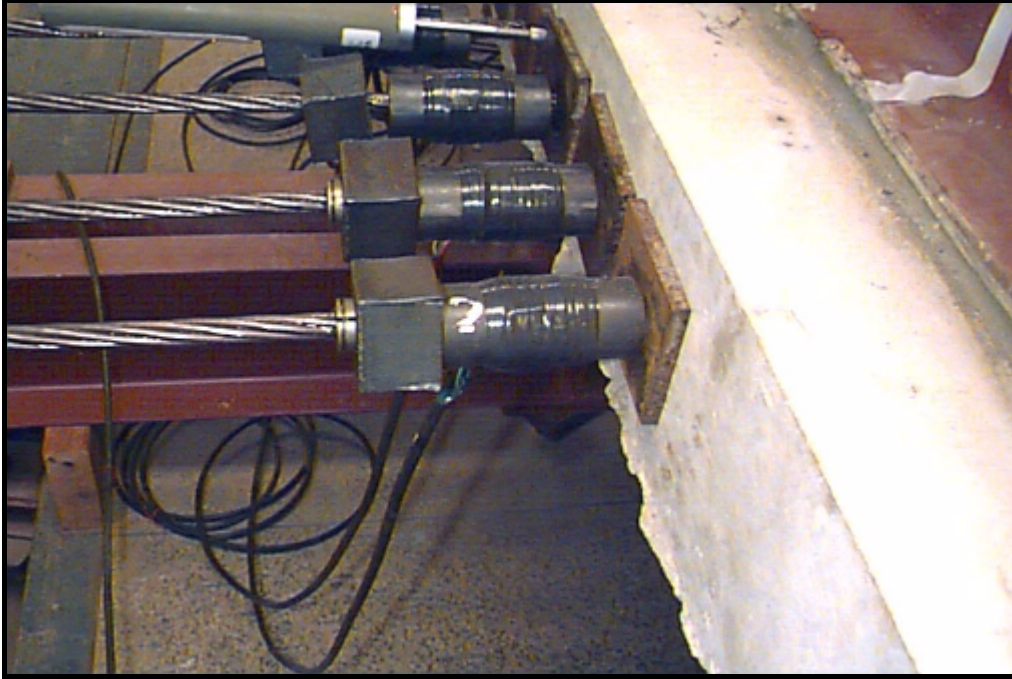
Figura 3.10 - Detalhe da montagem do sistema de ancoragem passiva
