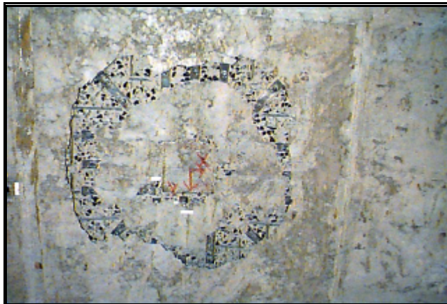
Figura 4.133 - Vista da face inferior
