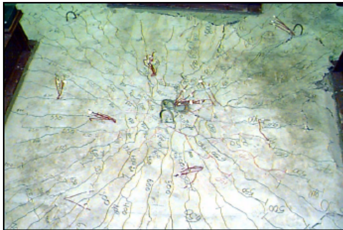
Figuras 4.146 - Vista da fissuração, na face superior, na região central do modelo, anterior ao carregamento pós-ruptura
