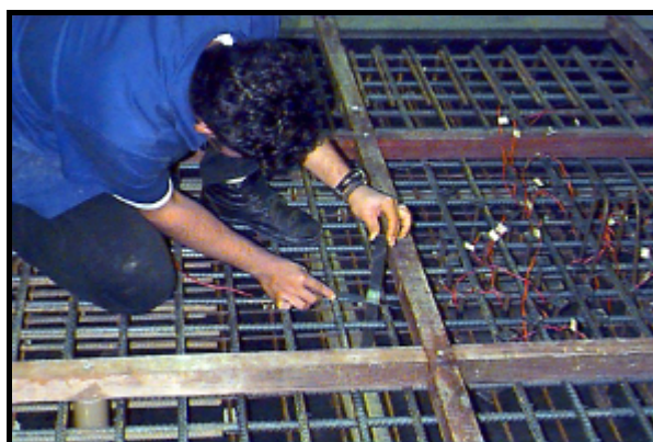
Figura 3.62 – Posição e modo como foram medidos os cobrimentos
