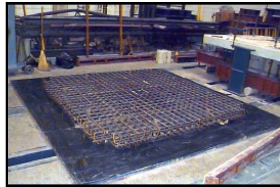
Figura 3.50 - Vista do modelo com a armadura já montada
