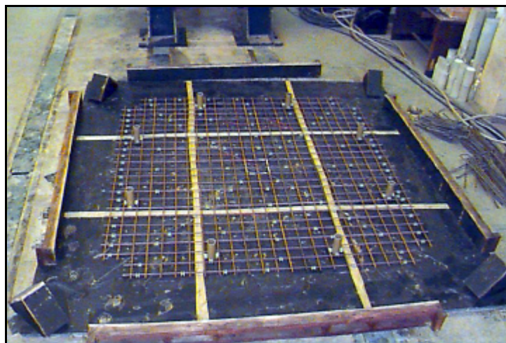
Figura 3.57 - Vista geral da disposição dos espaçadores plásticos
