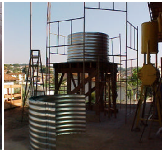
(e) Primeira etapa do silo montado na plataforma
