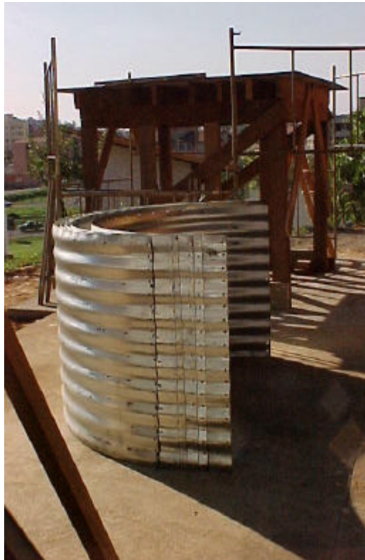
(a) silo aguardando ser montado
