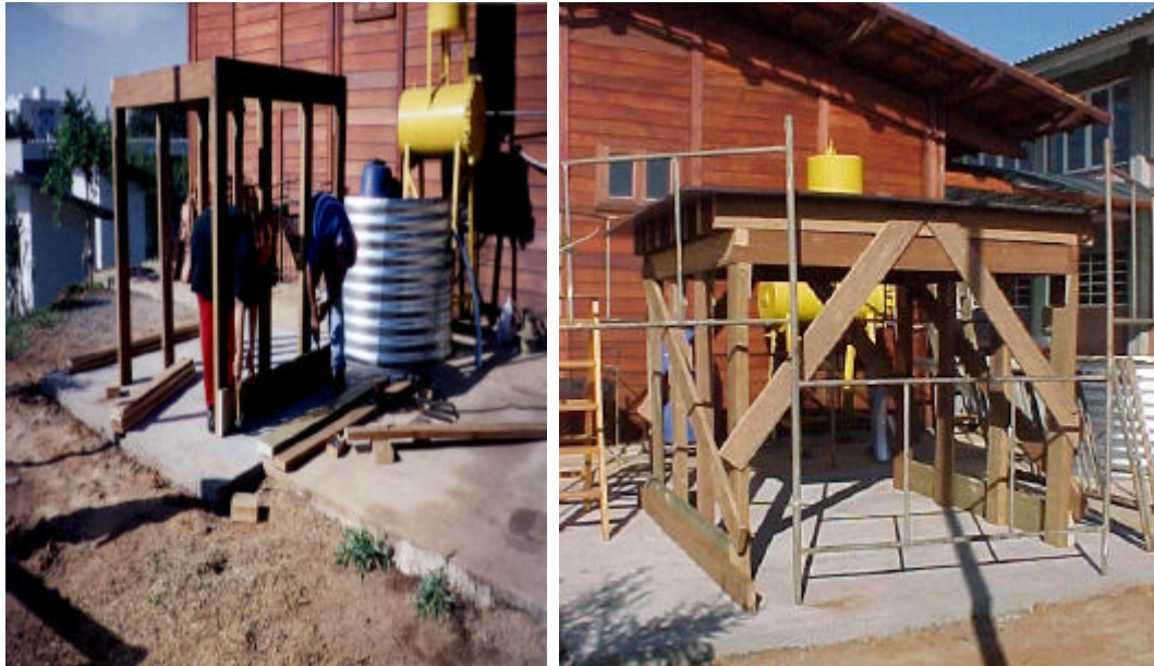
(a) Montagem da plataforma
