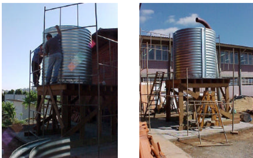
(a) Montagem da segunda parte do corpo do silo (b) Silo montado para execução da primeira série de ensaios h/d=0,98
