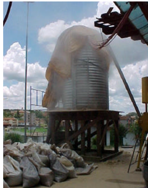
(b) Silo em carga
