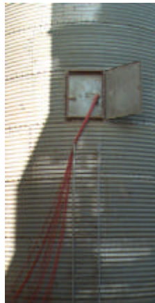
(b) Silo em operação
