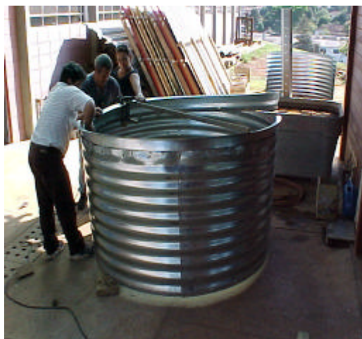
(d) Montagem da chapa de vedação
