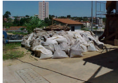
(b) Areia ensacada para o carregamento
