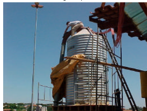
(f) Reparo na tubulação do carregador pneumático
