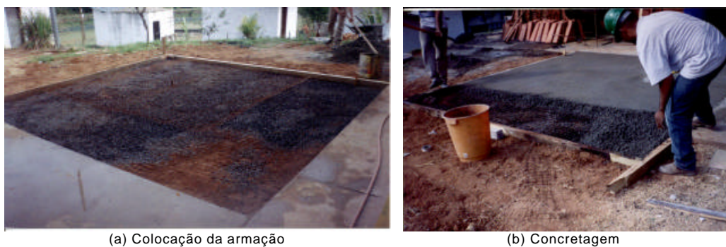
FIGURA 50– Execução da base da plataforma de madeira
