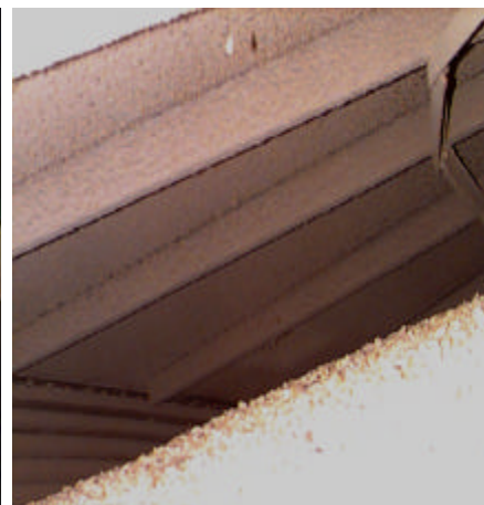
(e) Detalhe da superfície livre do produto no silo totalmente carregado
