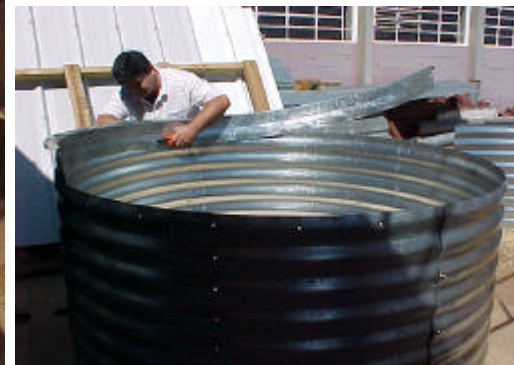
(c) montagem da chapa de vedação
