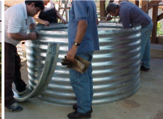
(b) Montagem da primeira parte do corpo de silo
