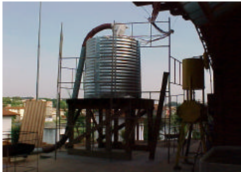
(a) Silo aguardando o carregamento
