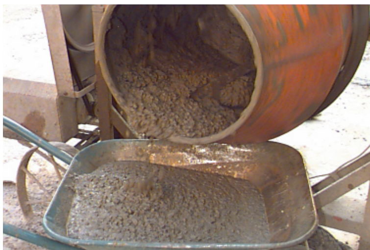
FIGURA 4.1 – Materiais na betoneira após a mistura
