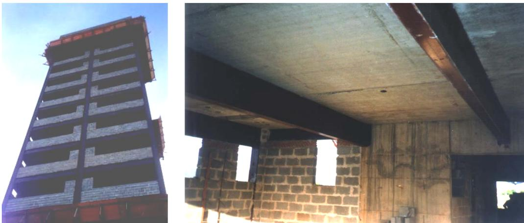
**FIGURA 1.10:** Exemplo de aplicação do sistema com núcleo estrutural de concreto em edifício de múltiplos andares – Ribeirão Preto/SP
