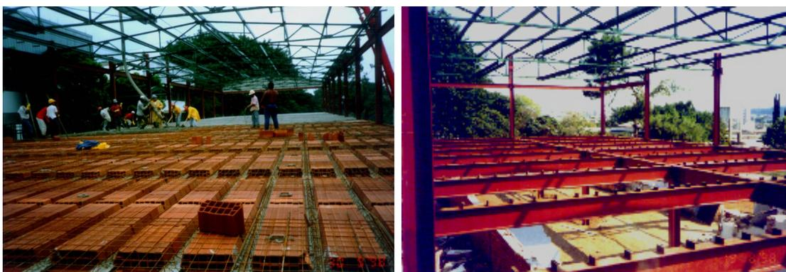
*FIGURA 1.3: Exemplo de aplicação de lajes nervuradas pré-fabricadas em piso de edifício*
