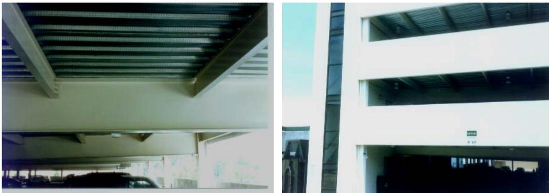
*FIGURA 1.2: Exemplo de aplicação do sistema de lajes mistas em edifício garagem*
