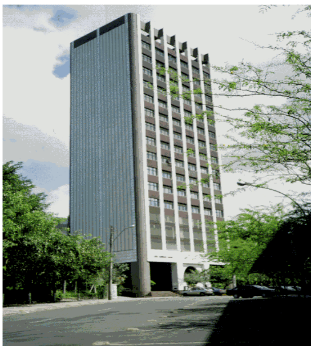
Figura 1.5: Edifício Banco de Tóquio, Salvador – BA. 16 pavimentos Fonte: http://www.stc.com.br/leiteemiranda/HighStrengthConcrete.html
