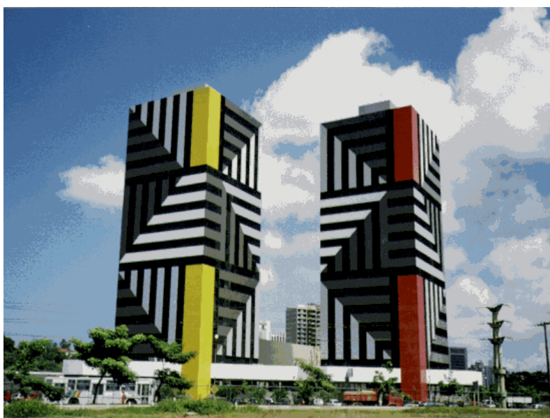
Figura 1.3: Centro Empresarial PREVINOR, Salvador – BA. 18 pavimentos
