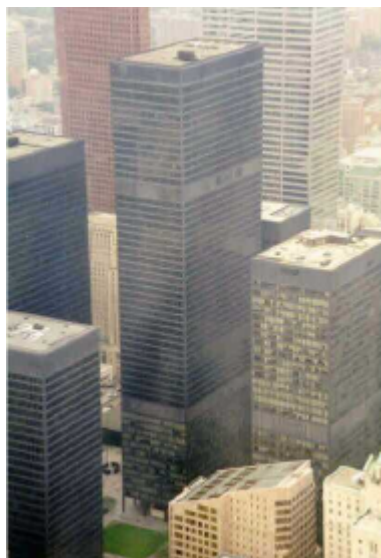
Fig.1.a- Centro de Toronto/ Canadá – Edifício TD BANK
