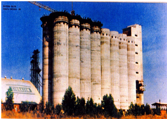
FIGURA 01(a) - Vista dos silos verticais de concreto armado. NEGRISOLI (1997).
