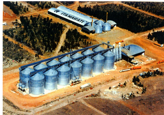
FIGURA 01(b) - Vista de uma bateria de silos metálicos. NEGRISOLI (1997).
