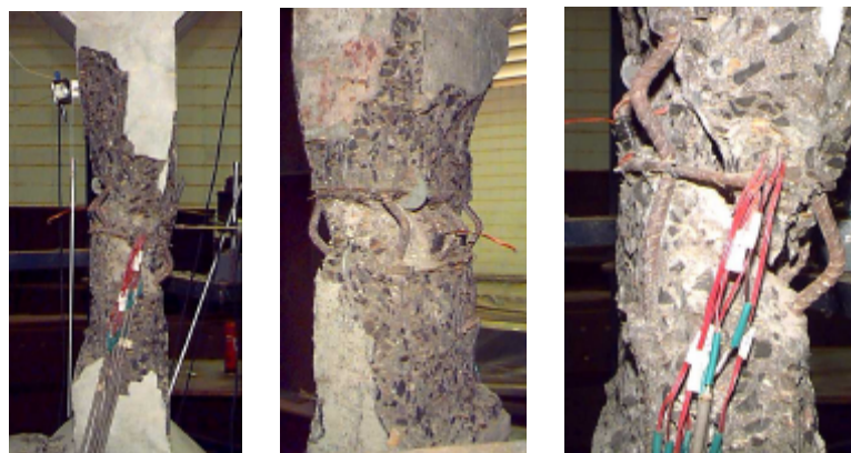
FIGURA 4.26 - Forma de ruptura do pilar P2/1
