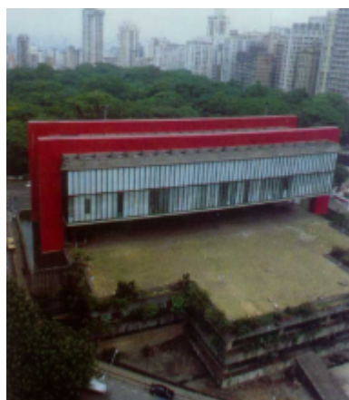
FIGURA 1.2 - Edifício do MASP, São Paulo [ROCHA (1997)]
