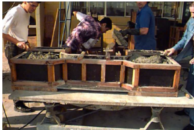
FIGURA 4.16 - Concretagem do pilar e adensamento em mesa vibratória
