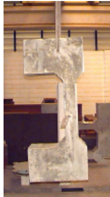
FIGURA 4.22 - Transporte do pilar até o pórtico de reação
