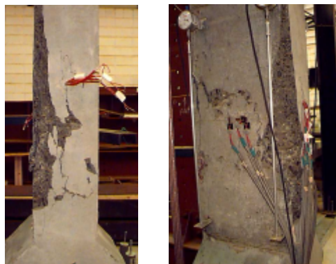
FIGURA 4.23 - Forma de ruptura do pilar P1/1R
