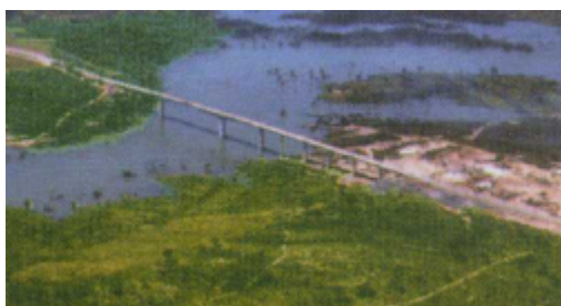
FIGURA 1.9 - Ponte sobre o rio Maranhão, Goiás. [CORBIOLI (1997)]
