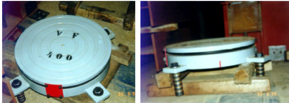
FIGURA 4.12 - Aparelho de apoio utilizado para liberar as rotações na base e topo do pilar
