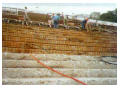
FIGURA 1.8 - Estádio do Pacaembú, São Paulo - SP. [ROCHA (1997)]
