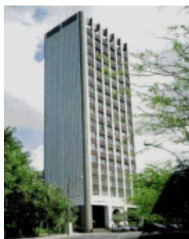
FIGURA 1.6 - Edifício Banco de Tokyo, Salvador - BA [LEITE & MIRANDA (1997)]
