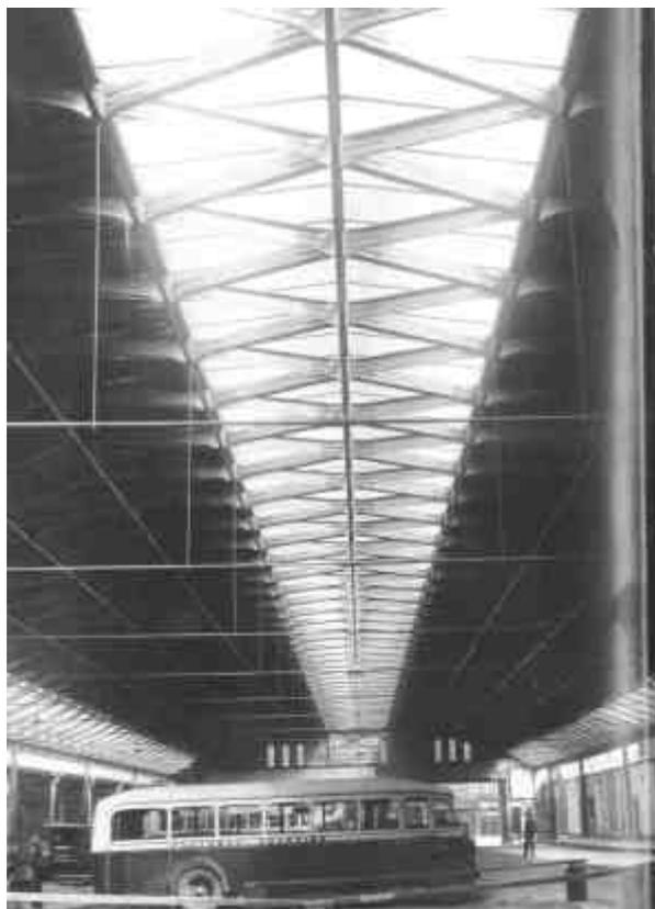
**FIGURA 27** – Estrutura lamelar em aço para cobertura de uma estação rodoviária em Belfast, Irlanda. Largura: 24 m. **Fonte: CASSIE & NAPPER (1958)**.
