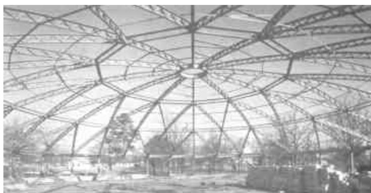
**FIGURA 33** – Cúpula lamelar com elementos treliçados de aço, construída em Arkansas, E.U.A. **Fonte:** MAKOWSKI (1984).
