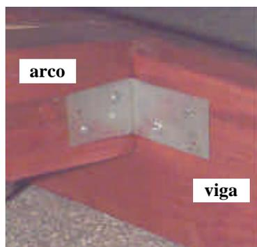
a) Vista da chapa metálica parafusada na viga e no arco.
