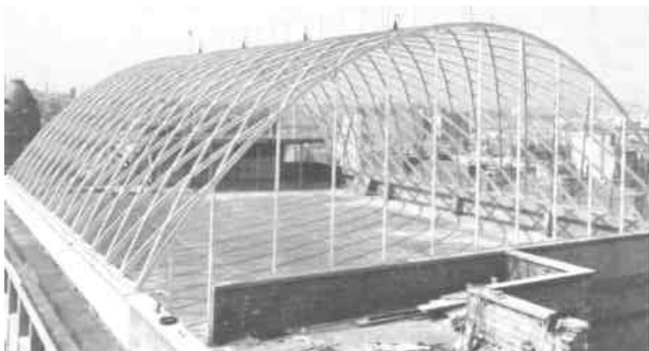
**FIGURA 26** – Abóbada lamelar em aço utilizada como cobertura de uma quadra de tênis, construída em cima de um prédio, em Paris. **Fonte: MAKOWSKI (1985)**.
