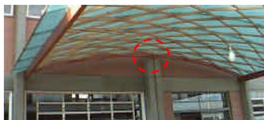
a) Arco encostado no pilar de concreto.
