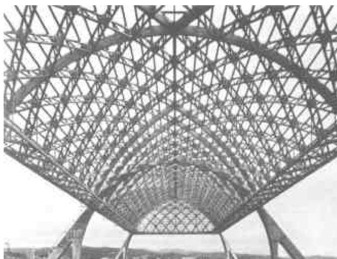
**FIGURA 29** – Abóbada lamelar constituída por elementos treliçados de aço, para cobertura de um hangar construído em 1935, em Cecchignola, próximo à Roma. Dimensões em planta: 36,6 m x 102,5 m. **Fonte:** MAKOWSKI (1985).
