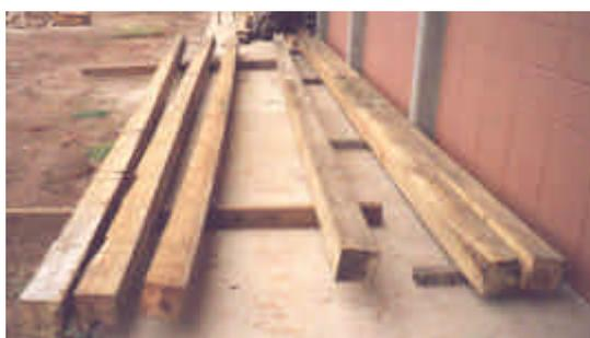
**FIGURA 112** – Vigas utilizadas para a confecção das lâminas dos arcos.
