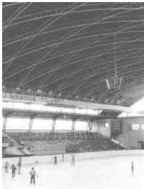
**FIGURA 31** – Vista interna de uma abóbada lamelar construída com elementos treliçados de aço, para cobertura de uma pista de hóquei em Berlim. **Fonte:** ZEMAM (1985).
