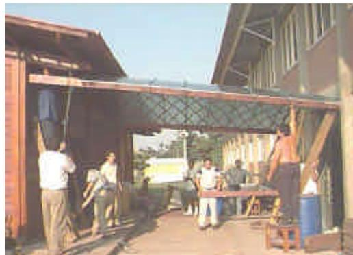
c) Levantamento da outra extremidade da estrutura com vigotas de madeira.
