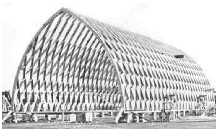
**FIGURA 16** – Abóbada lamelar em madeira, apoiada sobre contrafortes. Fonte: CASSIE & NAPPER (1958).
