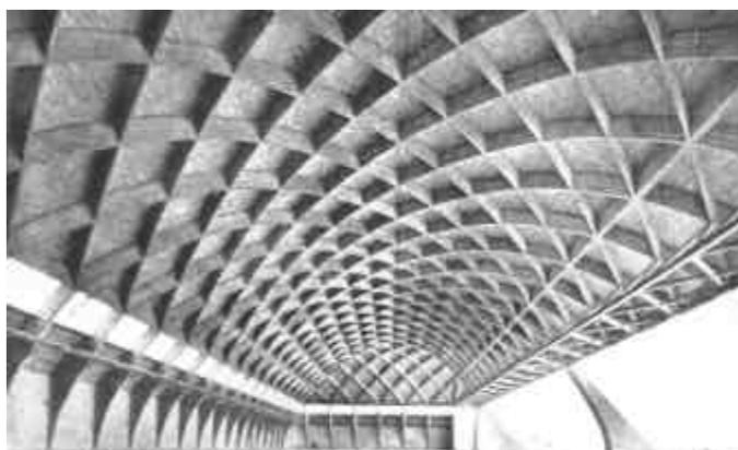
**FIGURA 39** – Estrutura lamelar de concreto armado pré-moldado apoiada sobre contrafortes, de um hangar construído em Orvieto, Itália. **Fonte: CASSIE & NAPPER (1958).**
