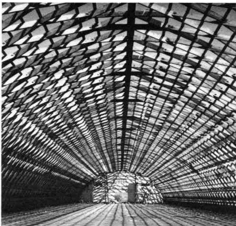
**FIGURA 13** - Estrutura lamelar de madeira construída em Berlim, em 1930. Fonte: **VON BÜREN** (1985).
