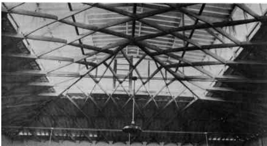
**FIGURA 7** – Estrutura lamelar de madeira em quatro águas construída no Brasil.
