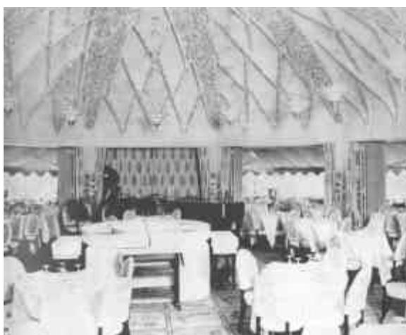
**FIGURA 35** – Vista interna de um salão coberto por uma cúpula lamelar decorada, em aço. **Fonte: CRANE (1955).**
