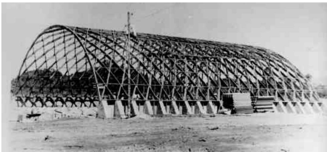
**FIGURA 1** – Estrutura lamelar de madeira construída na cidade do Rio de Janeiro na década de 50 deste século pela empresa SOCIEDADE TEKNO LTDA.
