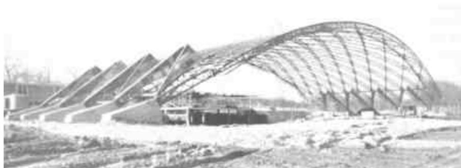
**FIGURA 30** – Abóbada lamelar constituída por elementos treliçados de aço, apoiada sobre contrafortes. **Fonte:** MAKOWSKI (1985).
