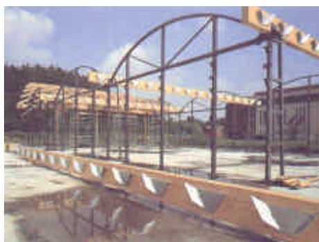
b) Vigas com chapas metálicas para a fixação das extremidades das lamelas.
