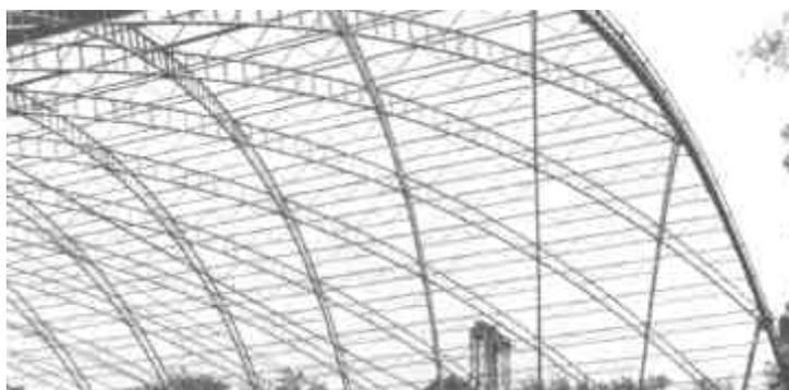
**FIGURA 32** – Estrutura lamelar com elementos treliçados de aço construída na Rússia. Largura da abóbada em planta: 45 m. **Fonte:** ZEMAN (1985).
