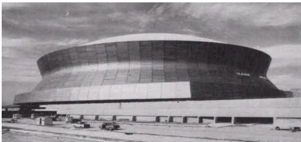
**FIGURA 36** – Ginásio de esportes coberto por uma cúpula lamelar em aço, construído em Louisiana, E.U.A., em 1971. Dimensões: 207 m de diâmetro e 30,5 m de altura. Fonte: CORPORATION OF MONTGOMERY (1975).
