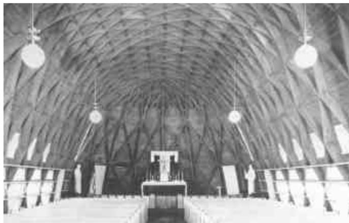
**FIGURA 20** – Vista interna de uma igreja construída com o sistema lamelar em madeira.
