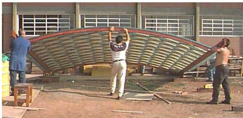
**Figura 12** a) Estrutura inclinada para o transporte.
