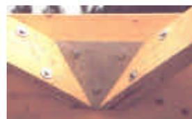
d) Detalhe da fixação das lamelas na viga.
