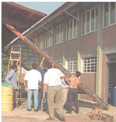
b) Extremidades das vigas penduradas com cordas no pórtico do telhado da oficina.
