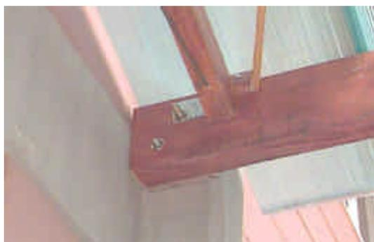
a) Extremidade fixada no pilar de concreto.
