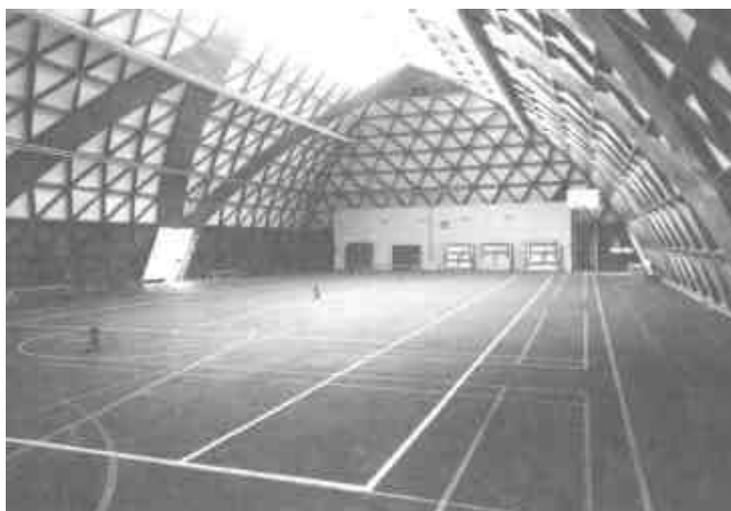
**FIGURA 21** – Vista interna de uma estrutura lamelar de madeira construída em Saint Edmund, E.U.A., para cobrir uma quadra de tênis de dimensões 18,3 m x 36,6 m. **Fonte: MAKOWSKI (1985).**
