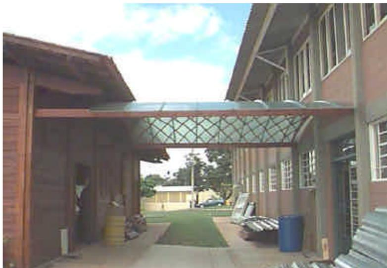
**FIGURA 2** – Protótipo lamelar montado no LaMEM para o desenvolvimento da pesquisa experimental deste trabalho. Dimensões em planta: 5,18 m x 4,00 m.
