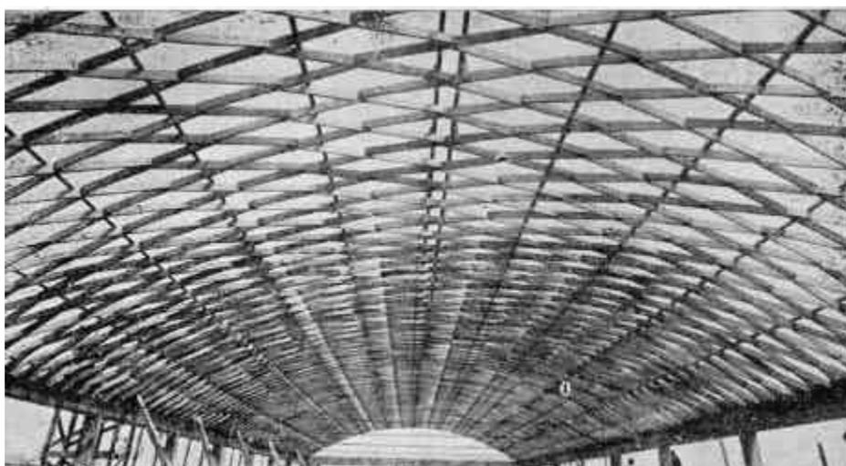
**FIGURA 5** – Estrutura lamelar de madeira construída em São Paulo em 1950 pela empresa A. SPILBORGHS & CIA LTDA. Fonte: ESTRUTURA (1951).
