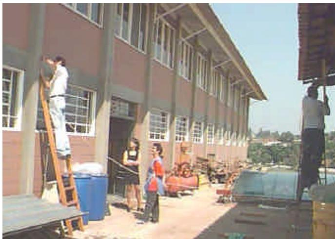
**FIGURA 11** – Determinação dos níveis para a fixação das vigas do protótipo.
