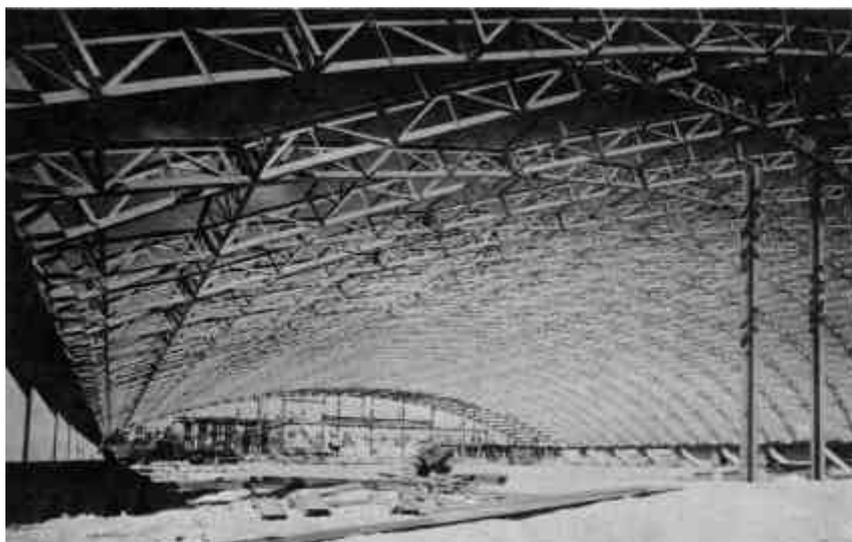
**FIGURA 28** – Abóbada lamelar constituída por elementos treliçados de aço.
