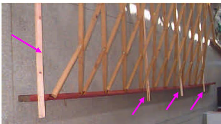
**FIGURA 129** - Posicionamento das vigas através de sarrafos.
