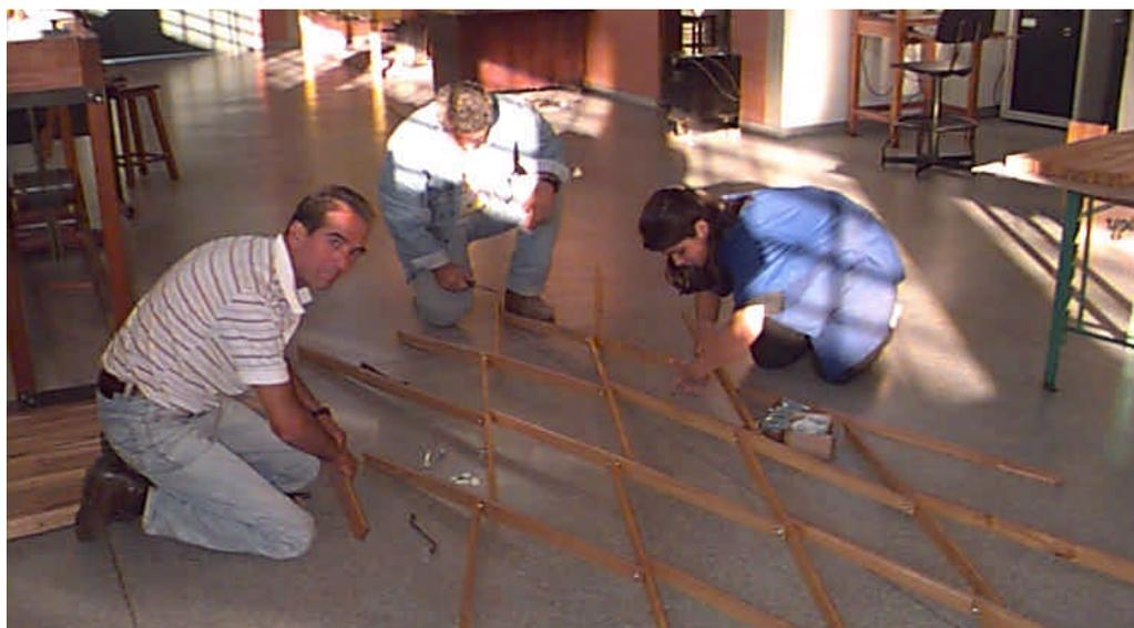
**FIGURA 108** – Montagem da malha lamelar.
