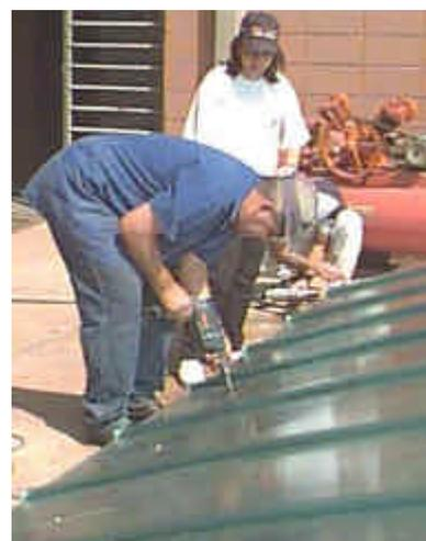
b) Fixação das telhas nas vigas.
