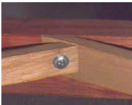
a) Vista das extremidades das lamelas parafusadas no arco.
