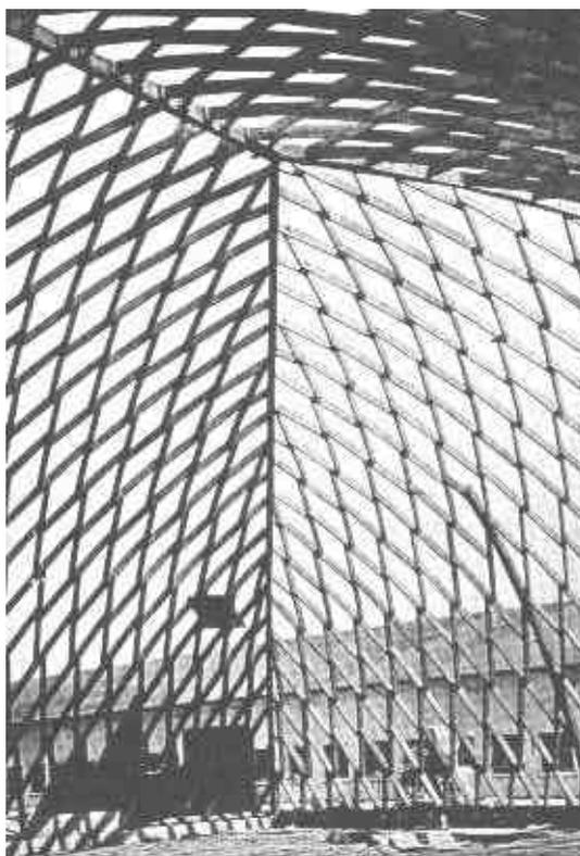
**FIGURA 17** – Estrutura lamelar de madeira apoiada sobre contrafortes.
