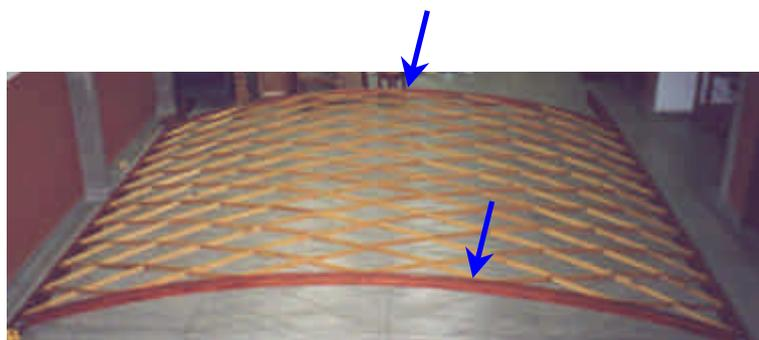
**FIGURA 110** – Arcos de madeira laminada colada que são apoios de extremidade da malha.
