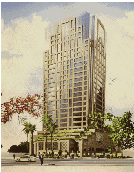
Figura 2.4.1. Edifício Comercial Suarez, Salvador - BA. Concreto de 60MPa utilizado no núcleo estrutural, LEITE & MIRANDA 4
