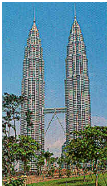
Figura 1.2. Torre Petronas (Malásia), a mais alta do mundo, concreto de 60MPa e 80MPa utilizado nos pilares 2
