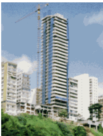
Figura 2.4.3. Edifício Arthur Moreira Lima, Salvador - BA. 33 pavimentos, 400m 3 de concreto de 60MPa nas paredes estruturais, LEITE & MIRANDA
