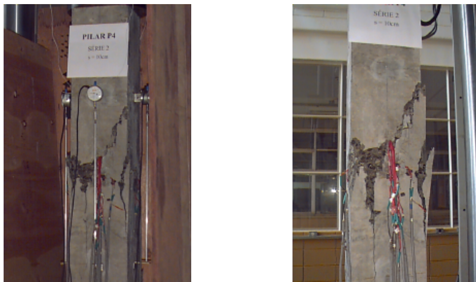
Figura 4.26. Aspecto do Pilar P4 após a ruína
