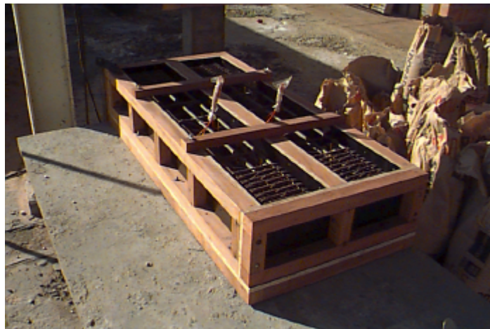
Figura 4.7. Detalhe da mesa vibratória com a fôrma já posicionada para concretagem
