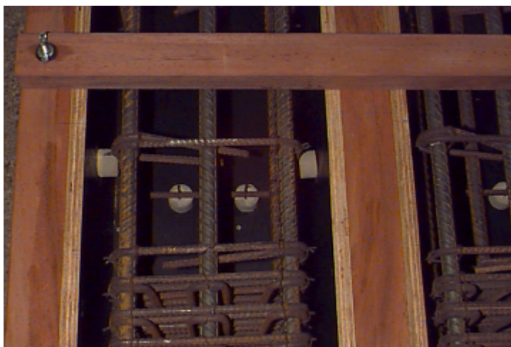
Figura 4.15. Detalhe dos espaçadores
