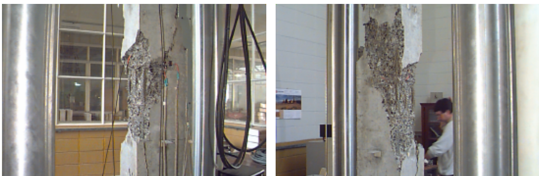
Figura 4.22. Aspecto do pilar P2 após a ruína
