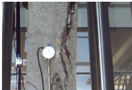
Figura 4.30. Aspecto do Pilar P6 após a ruína. A figura mostra a nítida separação da camada de cobrimento
