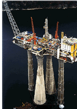
Figura 2.4.5. Estrutura offshore: plataforma Gullfaks C, 240.000m 3 de concreto de resistência característica variando de 65MPa a 70MPa utilizado na estrutura de gravidade da base 5
