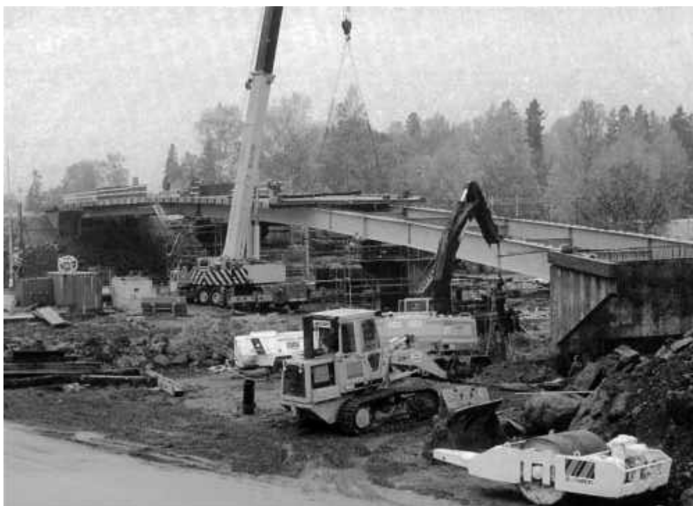
FIGURA 2.6 - Construção de viaduto em estrutura mista em Örbyhus, Suécia. COLLIN et al (1998) 1
