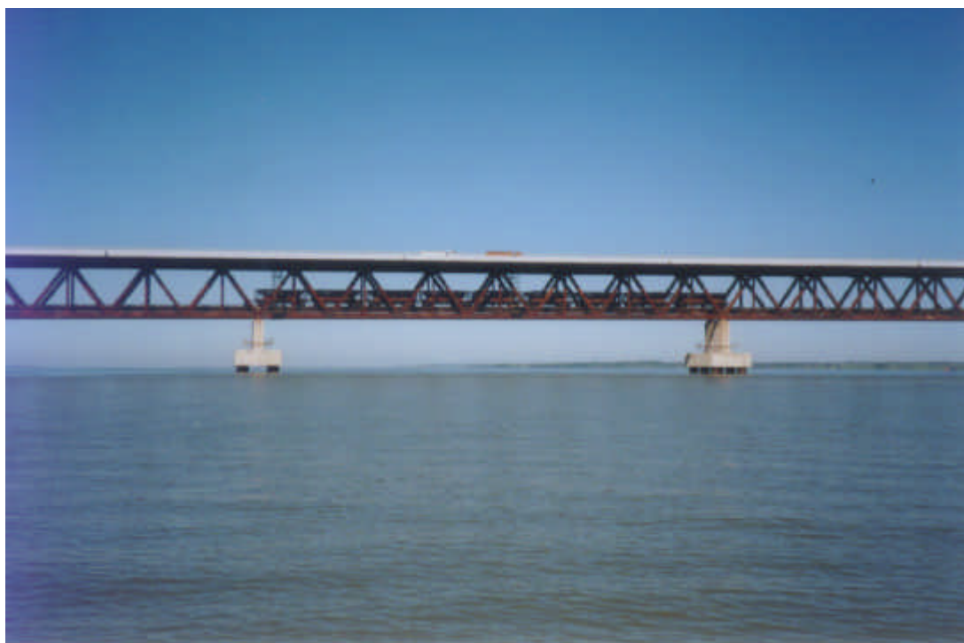
FIGURA 2.2 - Ponte rodo - ferroviária sobre o rio Paraná.
