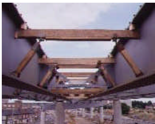
FIGURA 2.11 - Utilização de treliça para lançamento das vigas.
