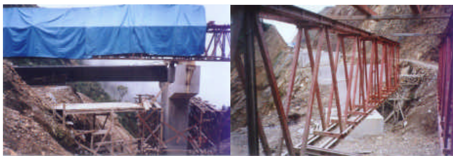
FIGURA 2.11 - Utilização de treliça para lançamento das vigas.
