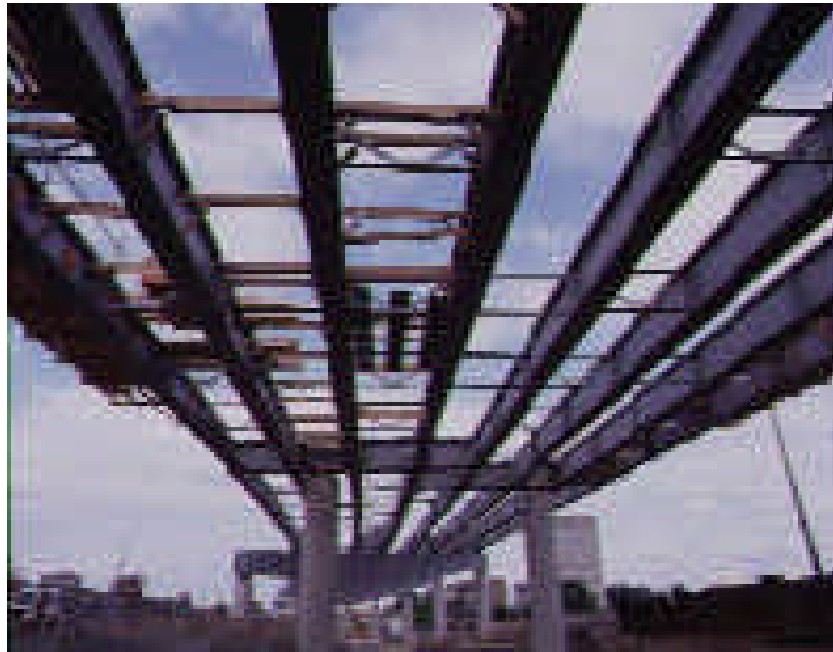
FIGURA 2.5 – Construção de viaduto em estrutura mista. HACKETT & ASSOCIATES (1998).
