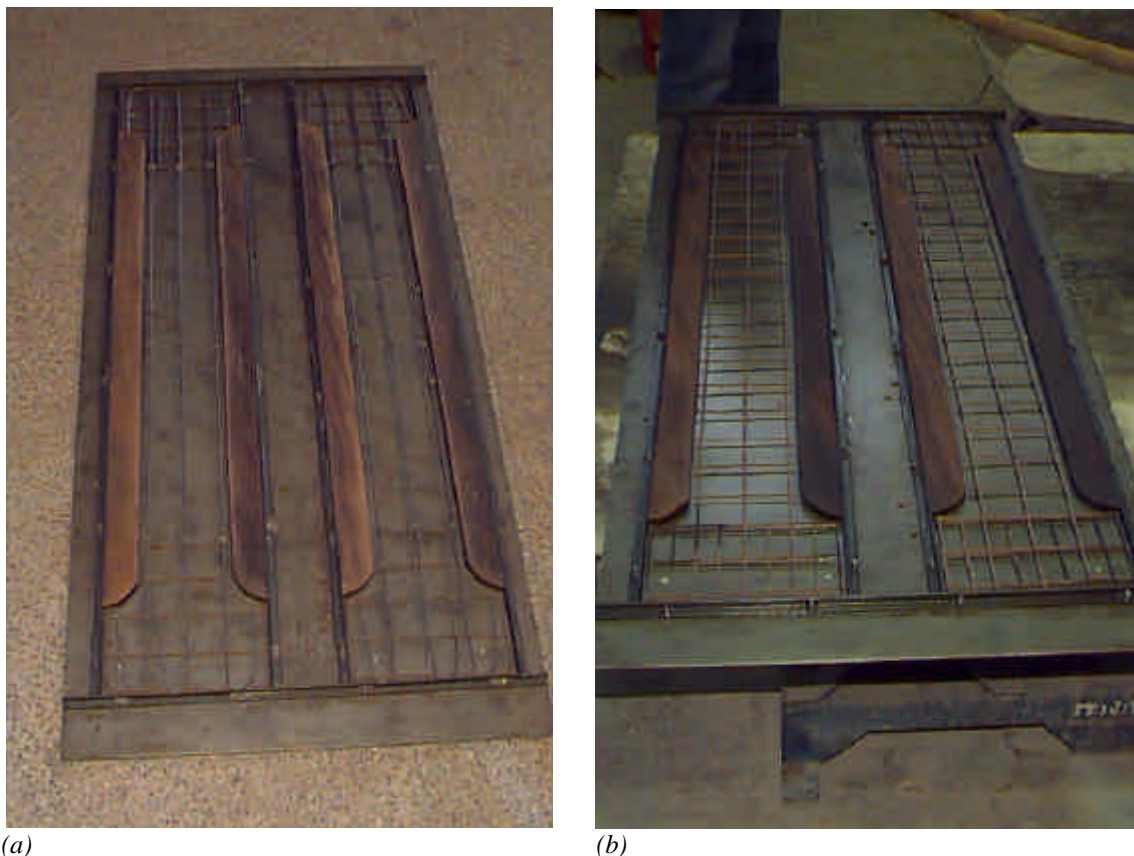
(a) Fig. 5.3: Esquema da montagem das armaduras na forma (a) forma com armadura de fio montada, e (b) forma com armadura de tela soldada.
