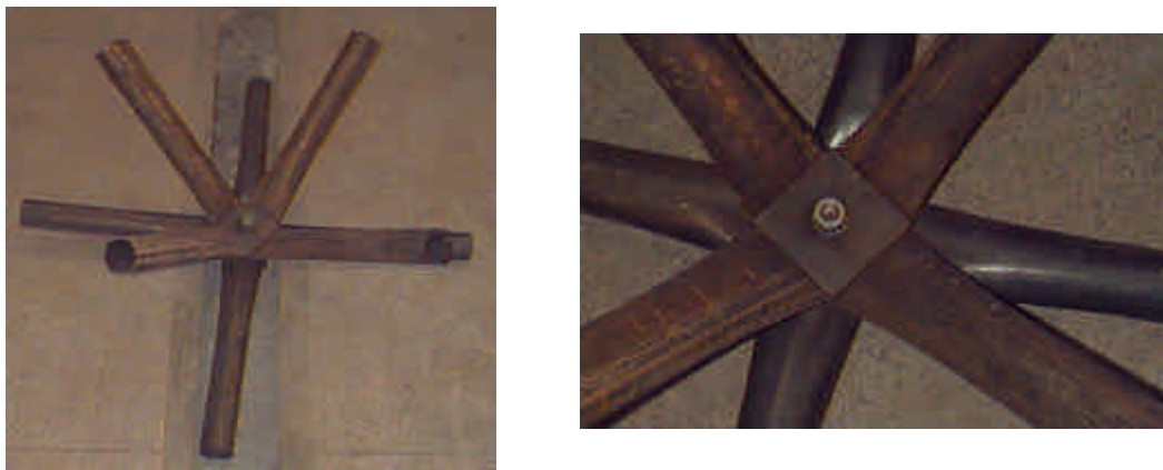
FIGURA 3.3 - Detalhe do nó típico
