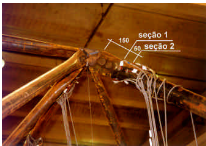
FIGURA 5.43 - Posicionamento da instrumentação nas extremidades das barras do vértice A do PROT 4
