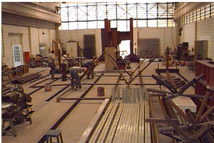
FIGURA 3.7 - Montagem do protótipo no piso do Laboratório
