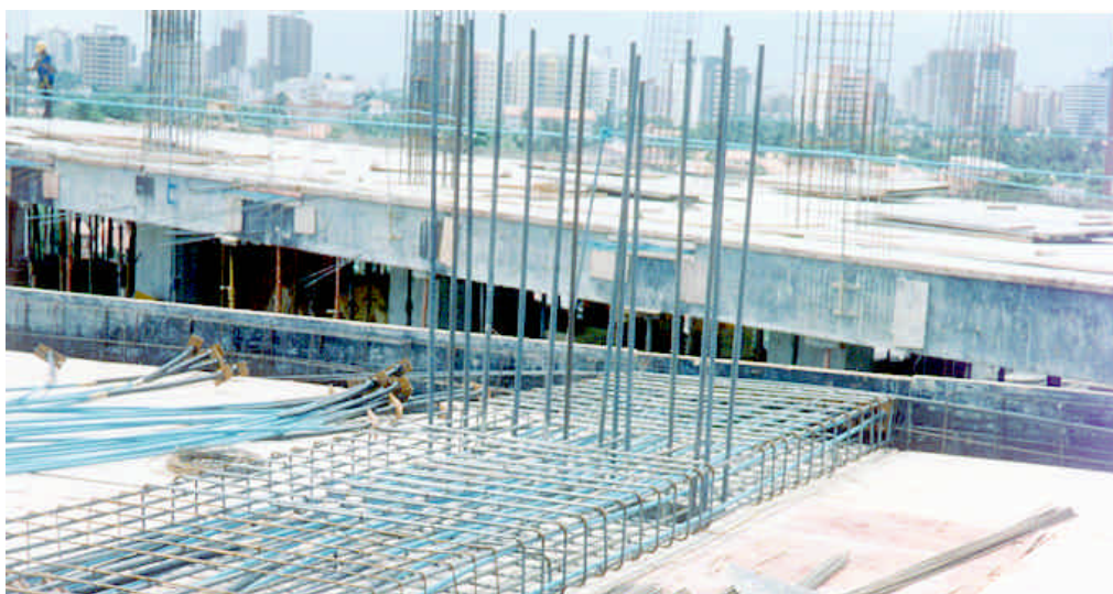
FIG. 6.5 - Armadura da viga-faixa protendida (Edifício late).
