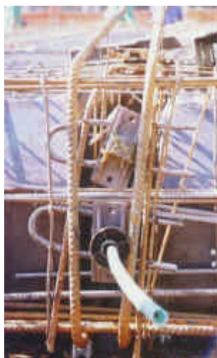
FIG. 6.2 - Ancoragens passiva e ativa.
