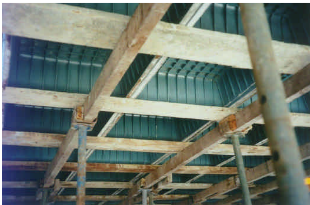
FIG. 4.7 - Escoramento dos caixotes sem assoalho.
