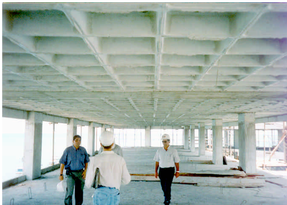
FIG. 6.8 - Característica de laje lisa (Edifício late).
