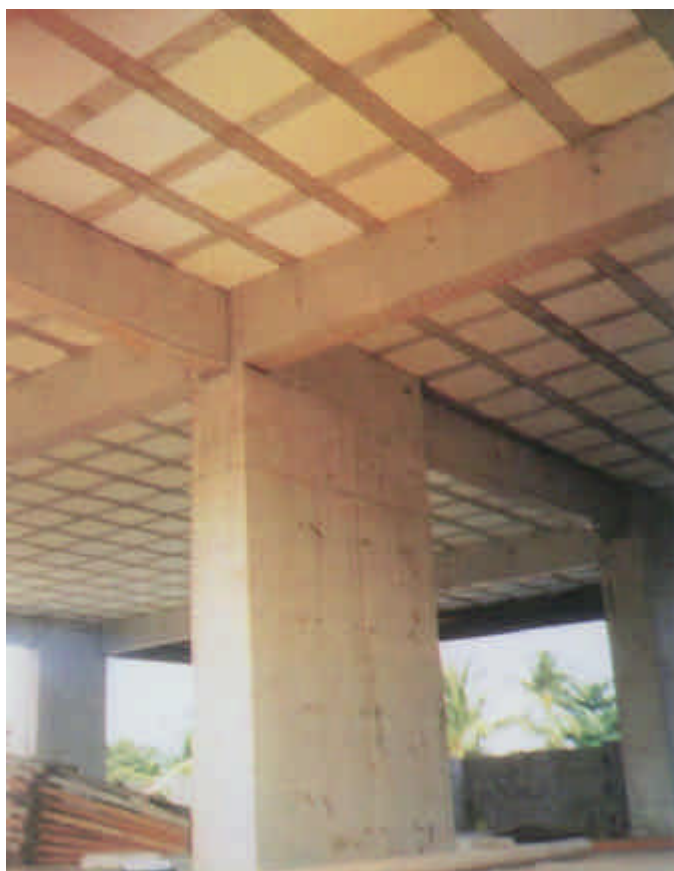
FIG. 4.11 - Laje nervurada treliçada bidirecional. (FRANCA, 1997)
