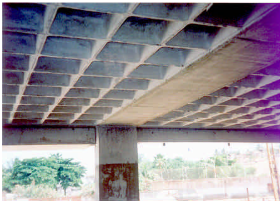
FIG. 6.7 - Viga-faixa (Edifício late).
