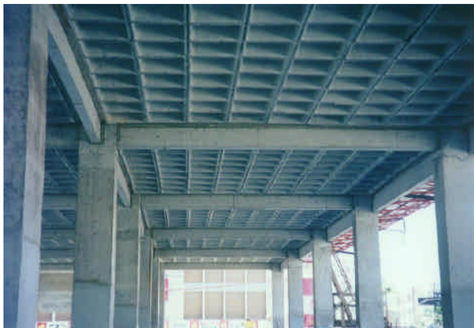
FIG. 4.4 - Laje nervurada construída com caixotes.
