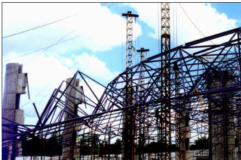
Figura 4.2 – Detalhe de montagem da cúpula
