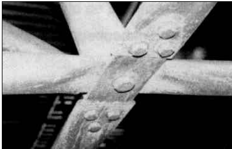
Figura 3.6 - Nó típico com chapa complementar
