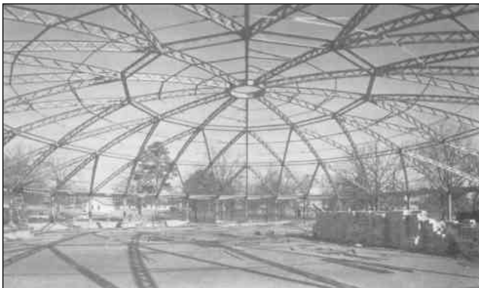
Figura 2.4 1 - Exemplo de cúpula constituída por lamelas
