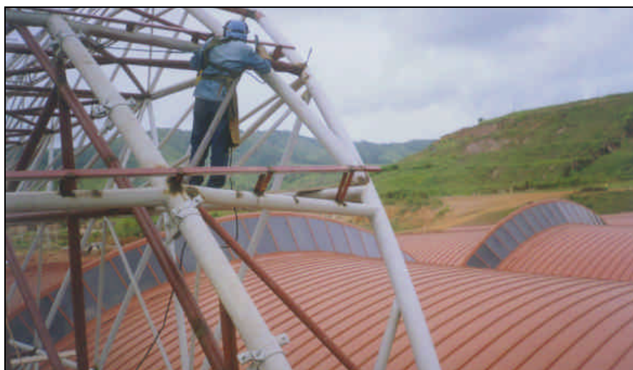
Figura 3.1 - Detalhe do nó com ligação soldada
