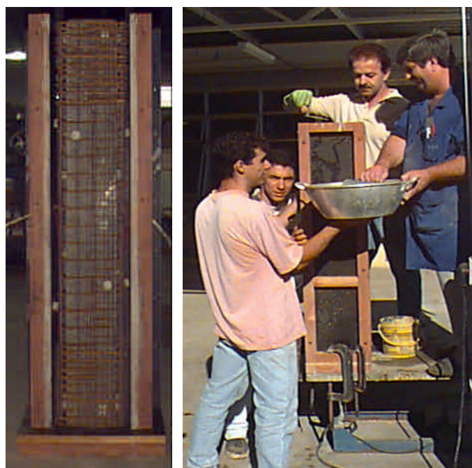
Foto 5.2 - Fotos fôrma e moldagem dos pilares reforçados
