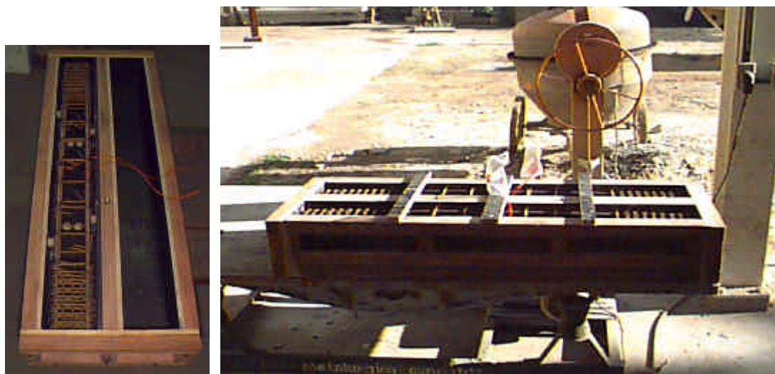
Foto 5.1 - Fotos fôrma e moldagem dos pilares de referência
