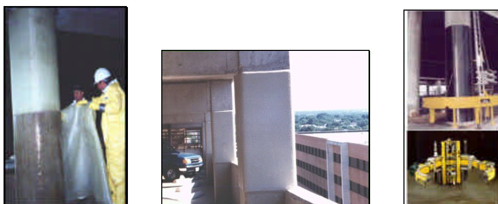
( a ) aplicação manual ( b ) aplicação em pilares retangulares ( c ) aplicação automática
