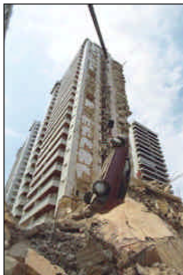
Figura 1.12: Vista do local do desabamento do Edifício Palace II - Rio de Janeiro-RJ (Brasil).
