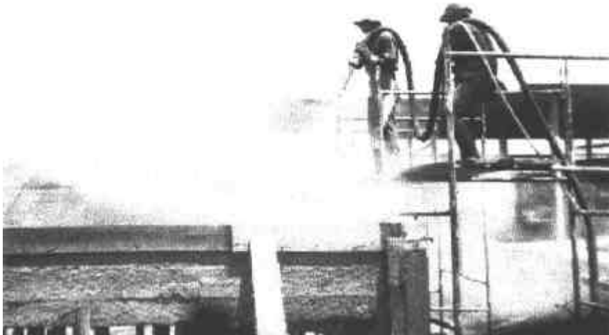
FIGURA 56. Concretagem da face superior do Protótipo II.
