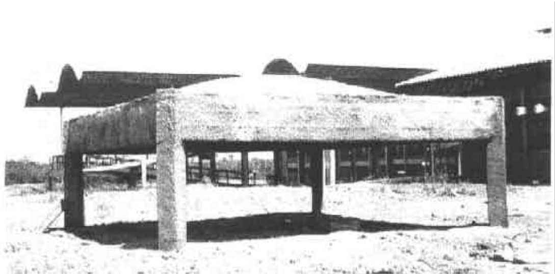
FIGURA 57. Vista do protótipo concluído.
