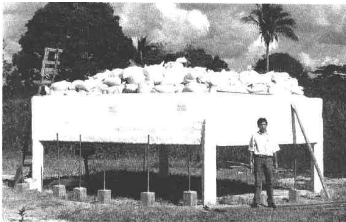
FIGURA 67. Protótipo II com toda a carga aplicada.
