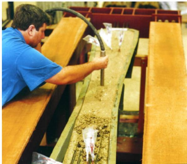
*Fig. 7.17 - Adensamento do concreto com vibrador de agulha*
