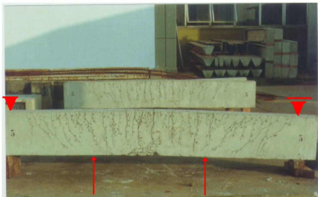
Figura 1.2. Distribuição característica das fissuras. ÁLVARES (1993).
