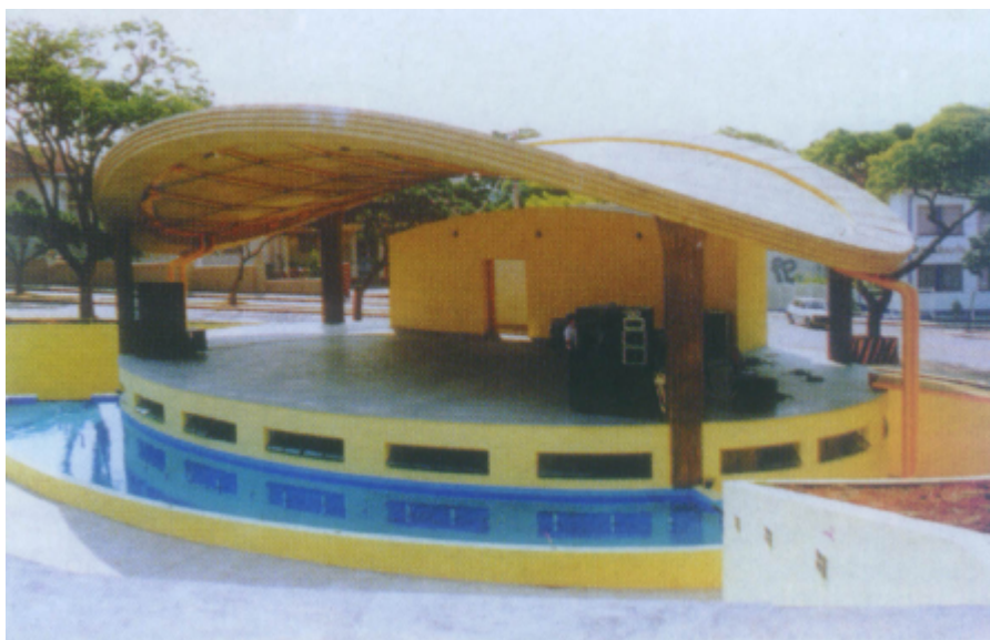
FIGURA 1.3.2: Teatro de Arena em São José do Rio Pardo, arquiteto L. P. C. Monteiro, engenheiros V. F. Arcaro e L. C. Almeida.
