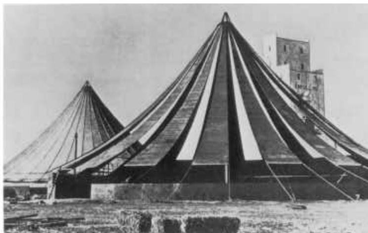
FIGURA 1.1.5: Coberturas com chapas metálicas suspensas sobre silos de armazenagem de grãos (USA).
