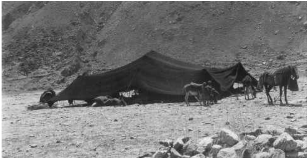
FIGURA 1.1.1: Tenda preta ( black tent ) utilizada no Afeganistão, construída com tecido de lã de cabra tingido, permitindo melhor ventilação e menor luminosidade interna.
