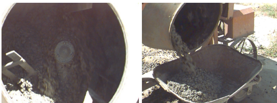
FIGURA 3.4 - Aspecto do Concreto Durante a Mistura e Lançamento
