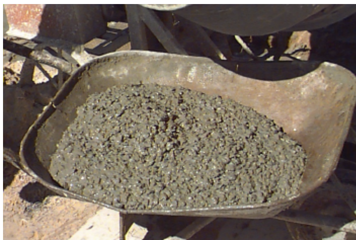
FIGURA 3.15 - Concreto para Moldagem do Pilar 3
