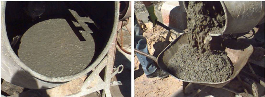
FIGURA 3.13 - Retirada do Concreto com Fibras Metálicas da Betoneira
