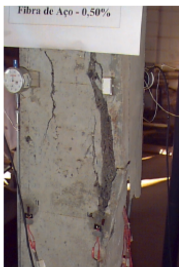
FIGURA 4.11 - Forma de Ruptura do Pilar Piloto 2
