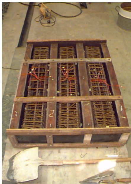
FIGURA 3.10 - Disposição das Armaduras com Espaçadores nas Fôrmas
