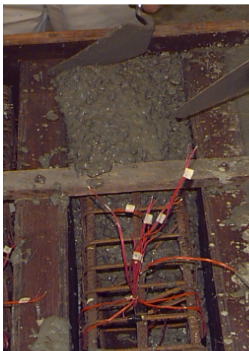
FIGURA 3.14 - Moldagem do Pilar Piloto 2
