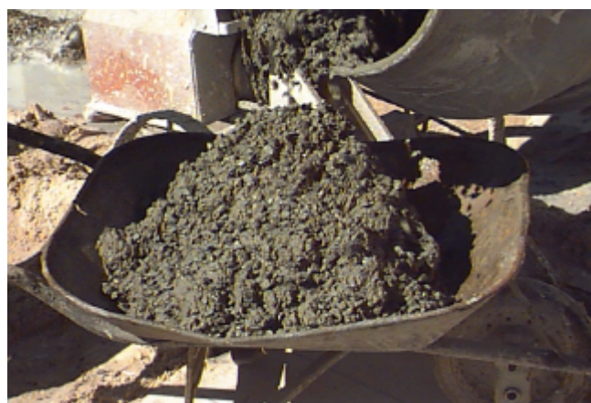
FIGURA 3.11 - Concreto com Fibras de Polipropileno (0,50% de taxa volumétrica)
