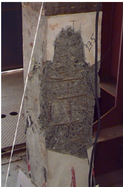
FIGURA 4.14 - Ruptura do Pilar Piloto 3
