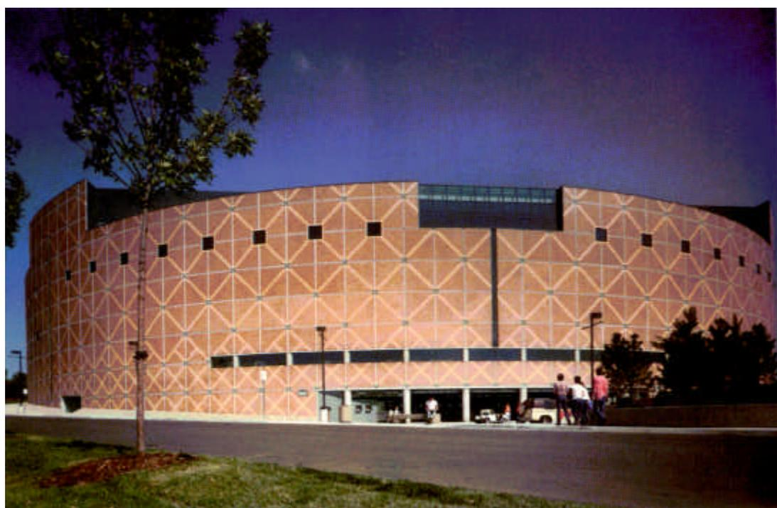
Figura 2.4- Edificações com painéis de concreto pré-moldado [PCI(1989)]
