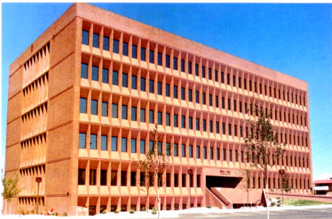
Figura 2.12- Exemplo de edificação de painéis como parede de contraventamento
