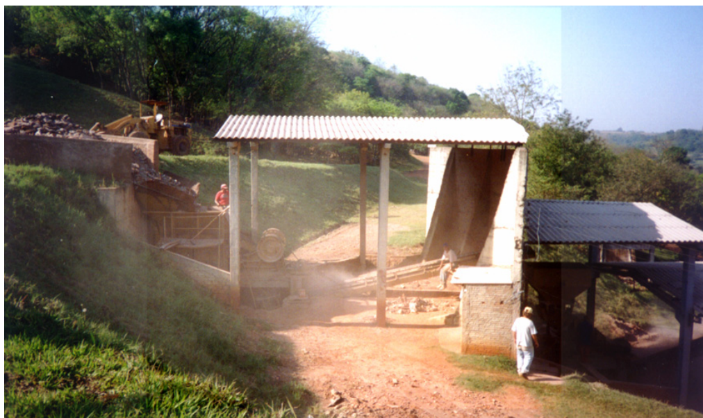
Figura 3.6 - Vista geral da Usina de Reciclagem de Londrina - PR com 2 britadores dispostos em série
