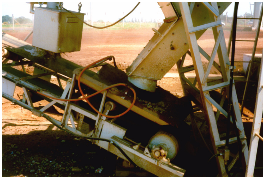
Figura 3.2 - Calha que alimenta o transportador de correia
