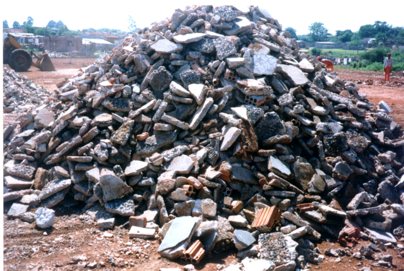
Figura 4.1: Pilha de entulho a ser britado
