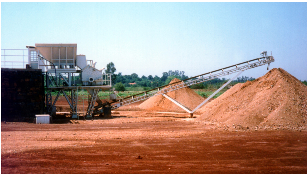
Figura 3.1 - Vista geral da Usina de Reciclagem de Ribeirão Preto
