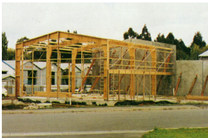
FIGURA 12 - Estrutura de residência utilizando madeira compensada - fonte: IPL
