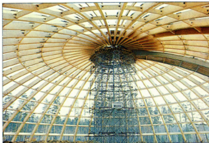
FIGURA 8 - Estrutura em cúpula utilizando madeira compensada - fonte: FPI
