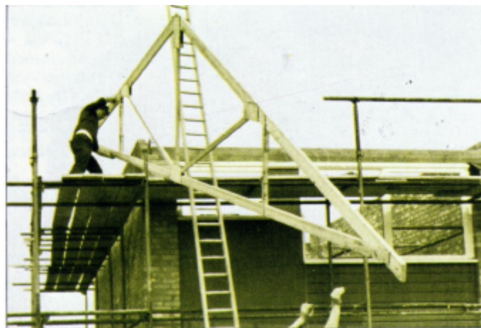
FIGURA 13 - Trelças utilizando madeira compensada como cobrejuntas - fonte: FPI
