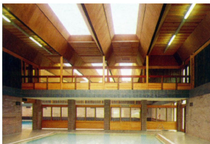
FIGURA 11 - Vigas compostas com madeira compensada - fonte: FPI
