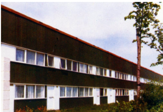
FIGURA 15 - Paredes externas utilizando madeira compensada - fonte: FPI
