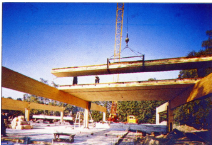
FIGURA 14- Painéis de piso pré-fabricados utilizando madeira compensada - fonte: FPI
