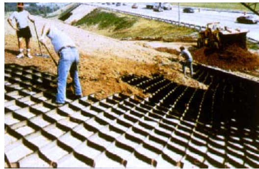
Fig. 4.18: Sistema de confinamento celular Geoweb (*)
