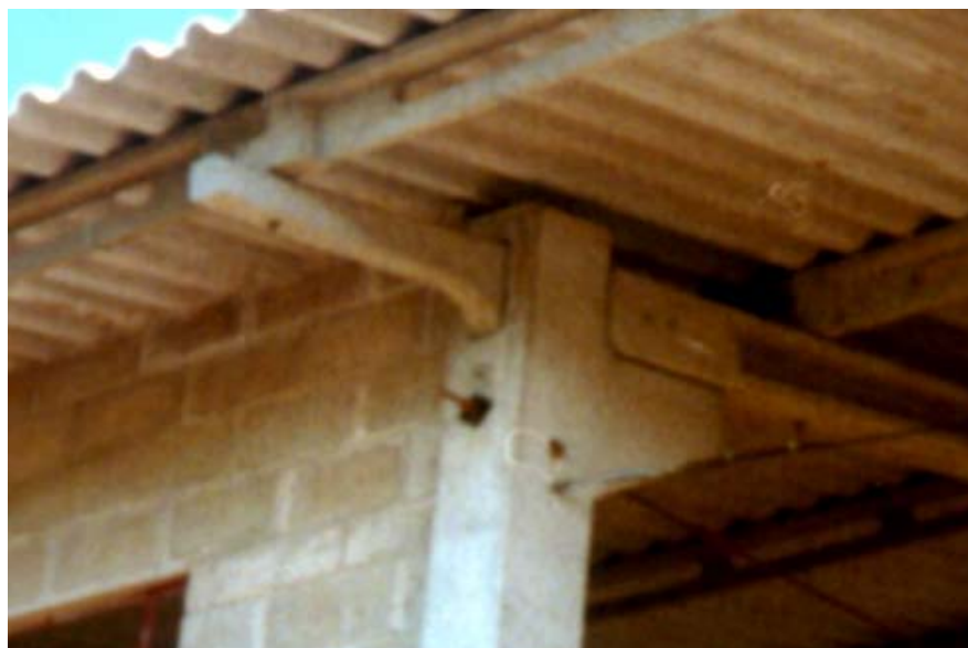
Figura 2.17 - Ligação viga-pilar - sistema passante.
