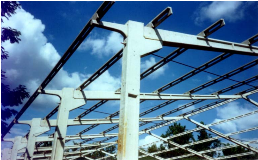
Figura 2.15 - Ilustração dos elementos estruturais dos galpões pré-moldados.
