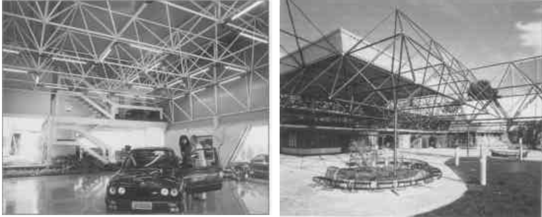
Figura 2.1 Treliças espaciais utilizadas como cobertura.
