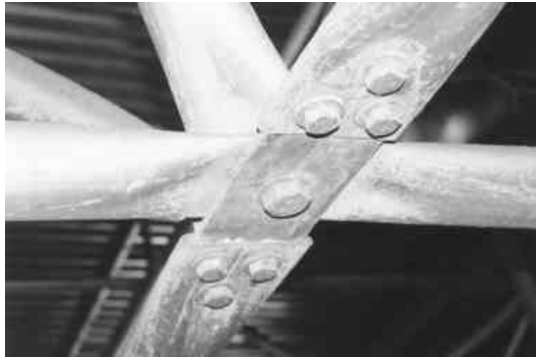
Figura 4.16 Nó típico com chapa complementar
