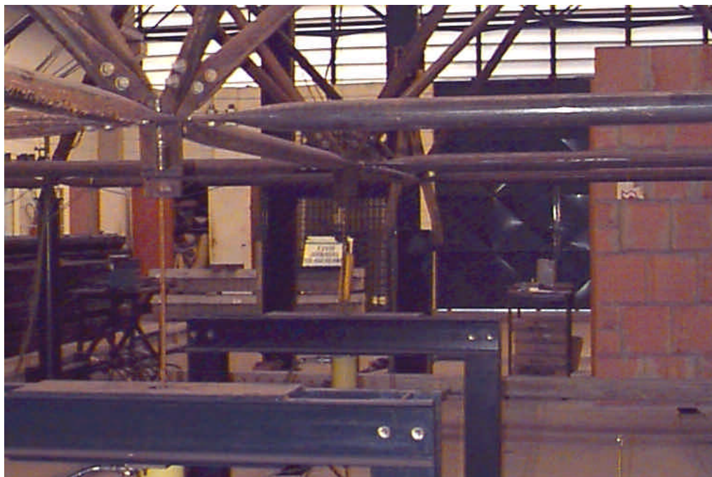
Figura 5.6 Detalhe do sistema de aplicação de força na estrutura.
