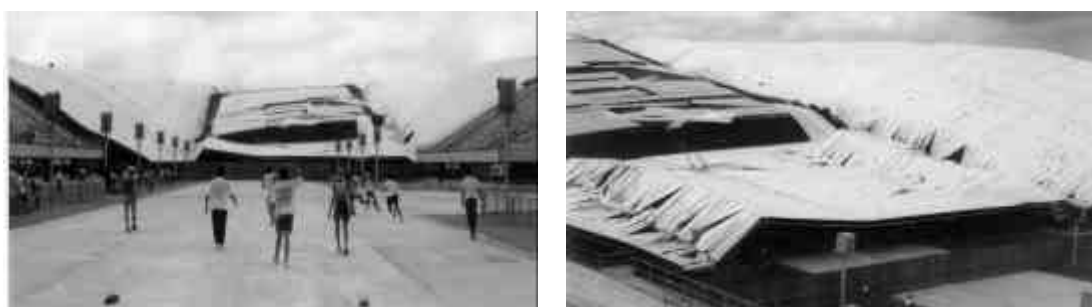
Figura 2.13 Colapso do Centro de Convenções de Manaus.
