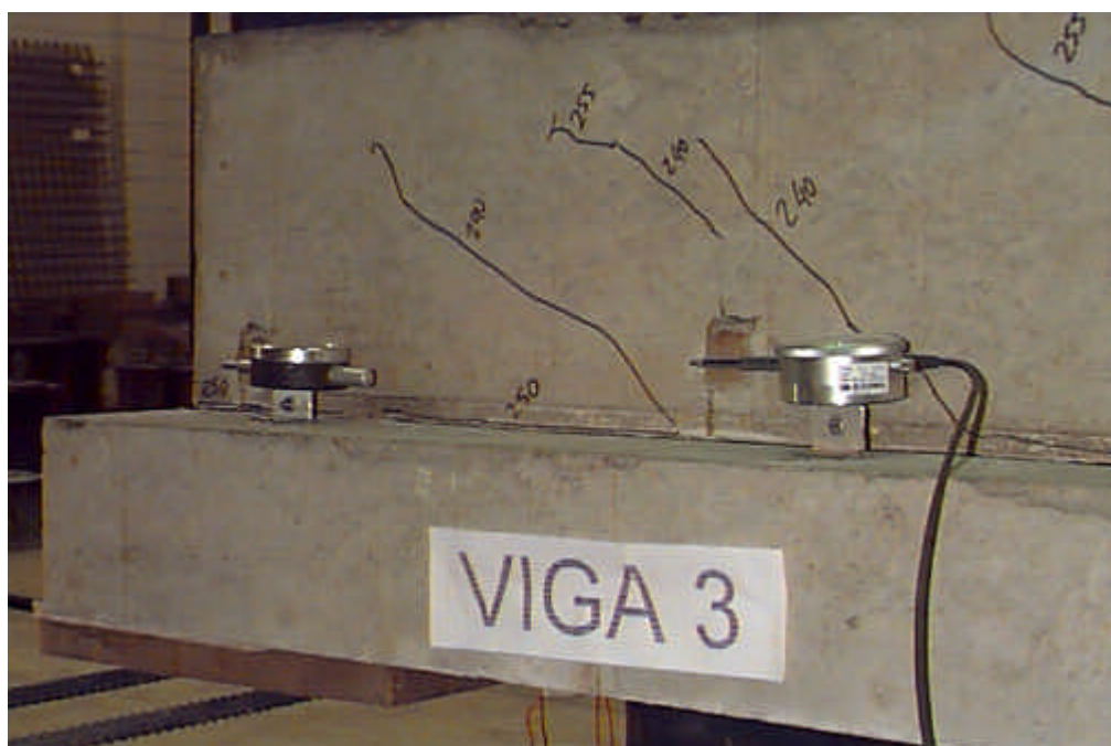
Figura 5.12(e) - Detalhe da fissuração da extremidade da viga 3.
