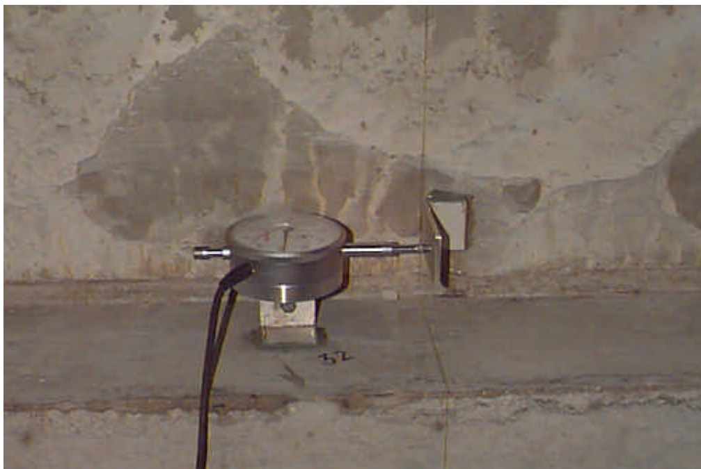
Figura 5.11(g) - Detalhe da fixação dos transdutores para medição do deslizamento relativo entre a mesa e a alma.
