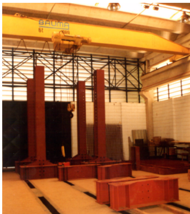
Figura 4.15 - Fotografia da montagem do pórtico de reação (colunas)
