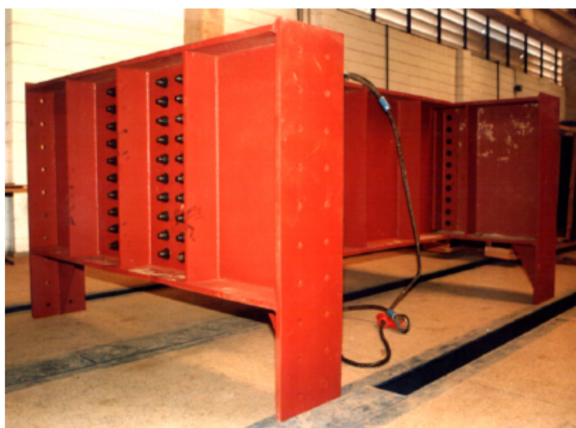
Figura 4.16 - Fotografia da montagem do pórtico de reação (grelha)
