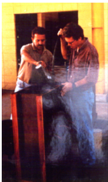
Figura 4.10 - lançamento e adensamento do concreto
